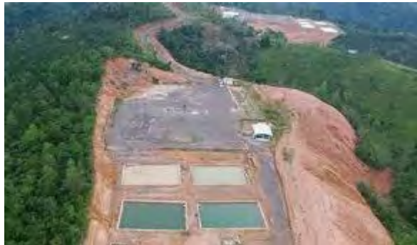
Gambar 1 1 Proyek PLTP Gunung Slamet
