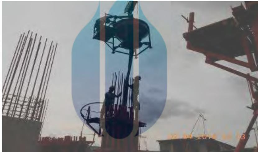
Gambar 5.10 Pengecoran kolom
