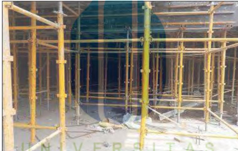
Gambar 5.13 Pemasangan *scaffolding* balok dan pelat lantai
