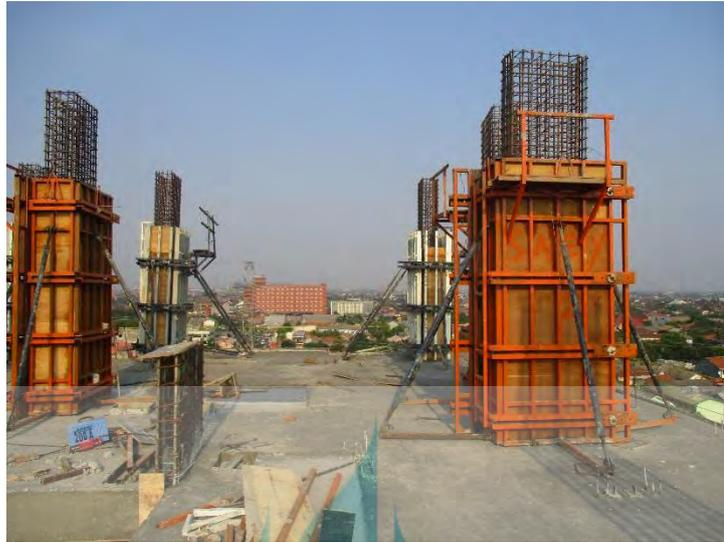
Gambar 5.9 Pemasangan *push pull prop*
