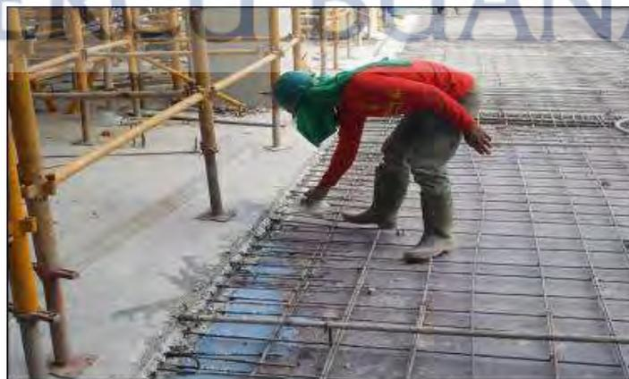
Gambar 5.19 Penyambungan pelat lantai dengan *calbond*
