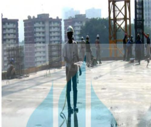
Gambar 5.23 Perawatan Beton dengan Penyiraman Air
