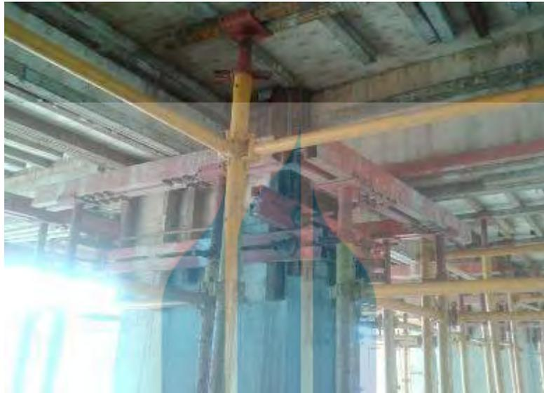
Gambar 5.14 Pemasangan bekisting balok dan pelat
