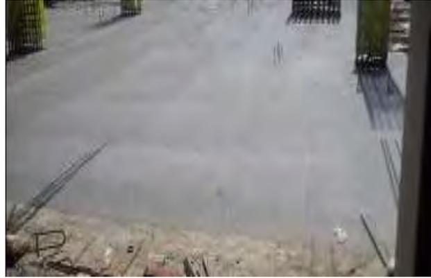
Gambar 5.21 Finishing Setelah Selesai Pengecoran
