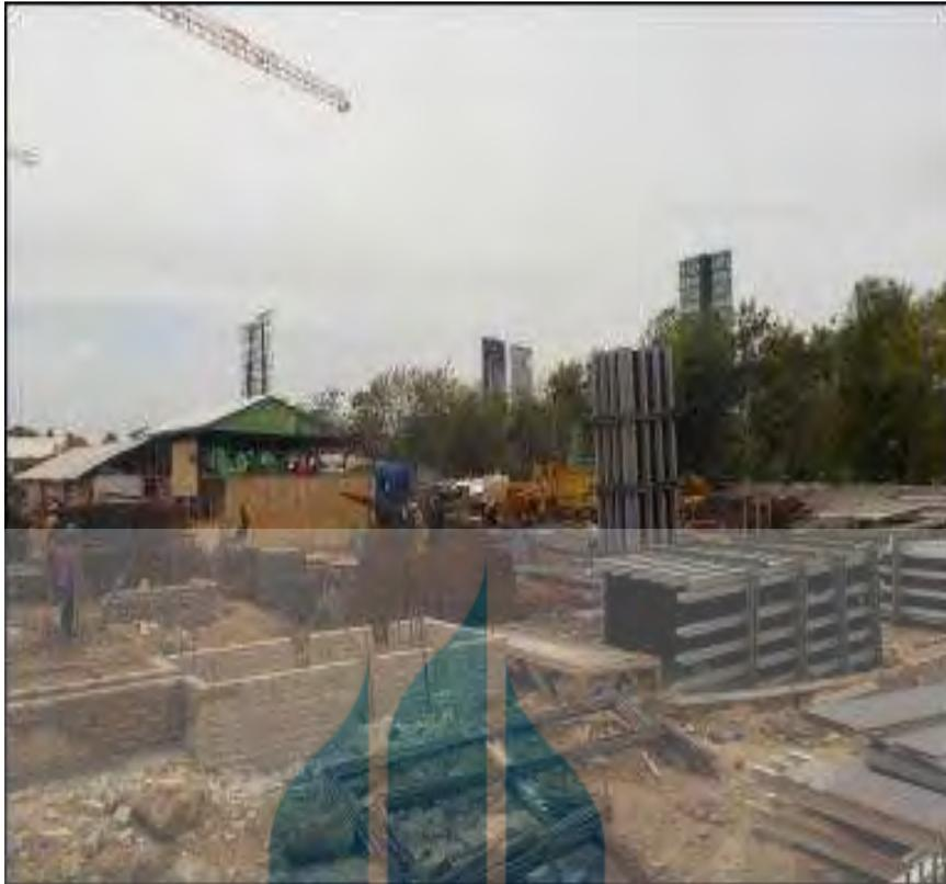
Gambar 5.7 Pabrikasi bekisting kolom
