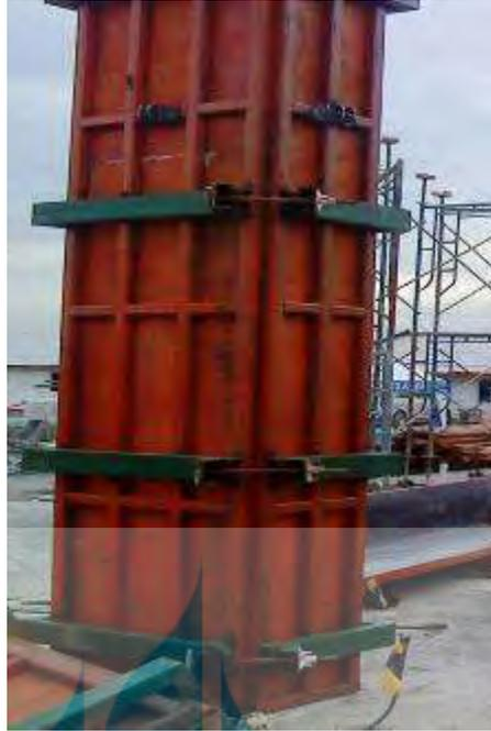
Gambar 5.2 Pemasangan bekisting kolom
