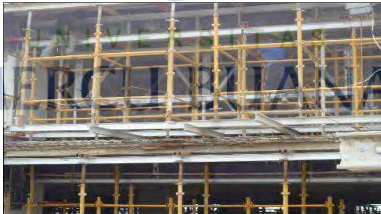
Gambar 5.22 Pembongkaran bekisting balok dan pelat lantai
