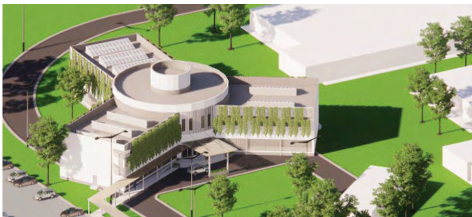
Gambar 4.28 Penggunaan energi terbarukan Solar Panel di atas bangunan
