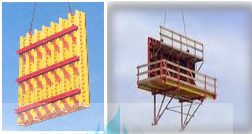
Gambar 7.3 Pemasangan bekisting bagian luar
