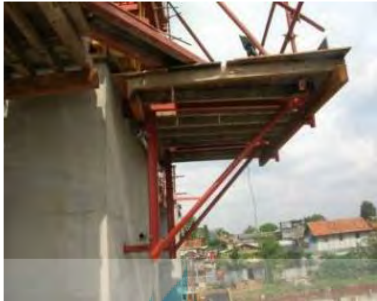
Gambar 7.12 Penempatan Platform Climbing Sumber : Data pelaksanaan lapangan, 2017
