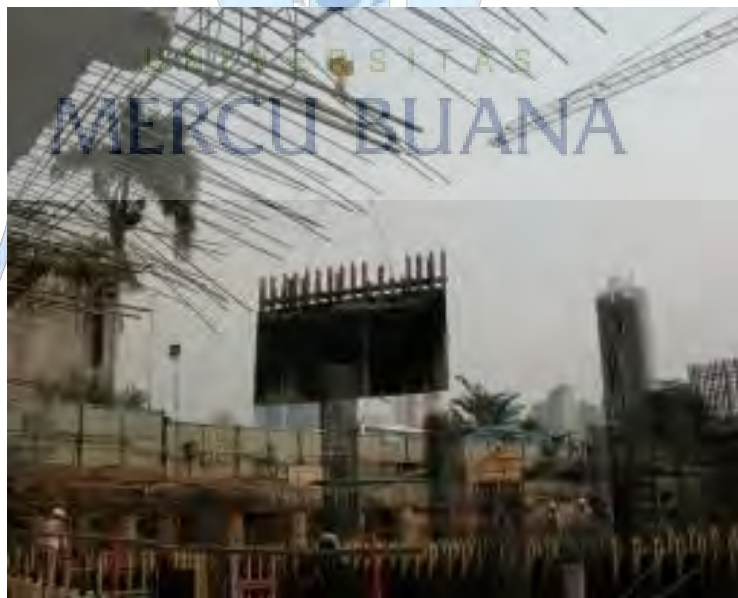
Gambar 7.13 Pengangkatan bekisting shear wall Sumber : Data pelaksanaan lapangan, 2017
