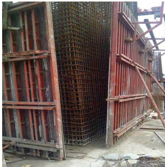
Gambar 7.14 Mengatur kelurusan bekisting
