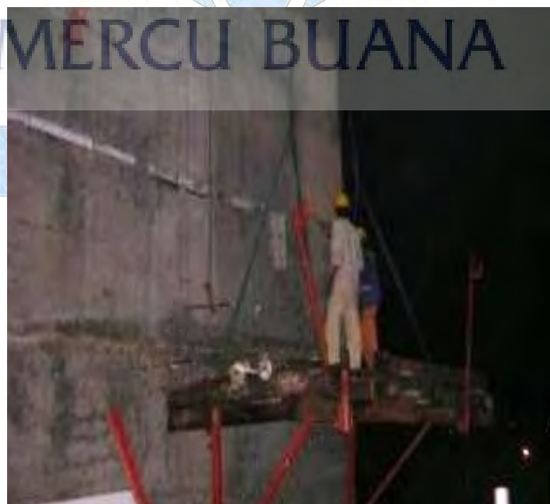
Gambar 7.11 Pengangkatan Platform Climbing Sumber : Data pelaksanaan lapangan, 2017
