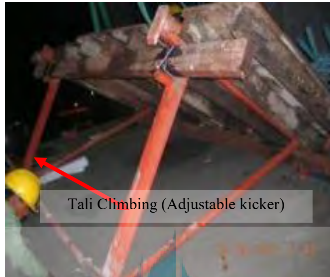
Gambar 7.10 Pemasangan tali climbing ( Adjustable kicker ) Sumber : Data pelaksanaan lapangan, 2017
