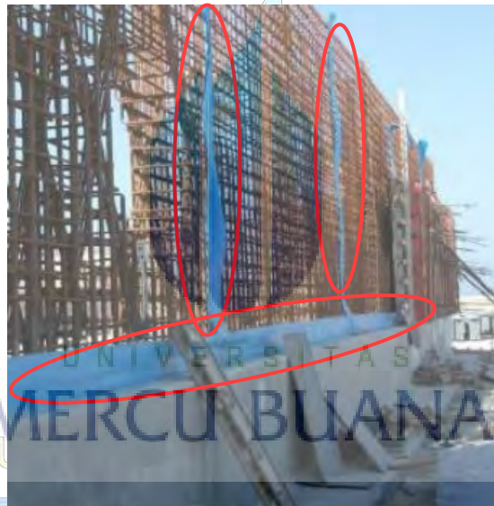
Gambar 7.16 Pemasangan waterstop pada core wall tulangan horizontal
