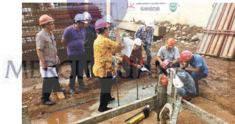
Gambar 7.14 : Uji Tarik Chemical Ramset
