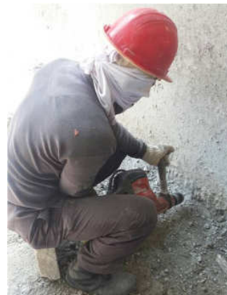
Gambar 7.7 : Proses Pengeboran Titik Chemical
