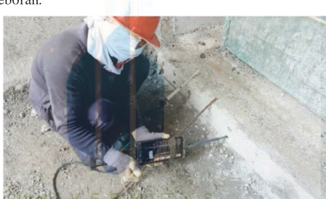
Gambar 7.11 : Proses Memasukan Cairan Chemical Ramset
