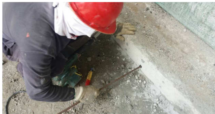
Gambar 7.12 : Proses Memasukkan Stek Besi Dalam Lubang
