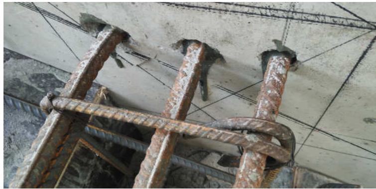
Gambar 7.13 : Hasil Chemical yang sudah di semprotkan di lubang dan dimasukkan besi stek
