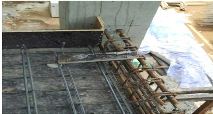
Gambar 7.6 : Stek tulangan pinggir balok bordes pada kolom
