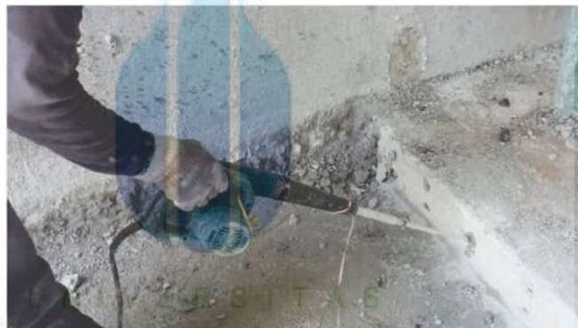
Gambar 7.9 : Pembersihan Lubang
