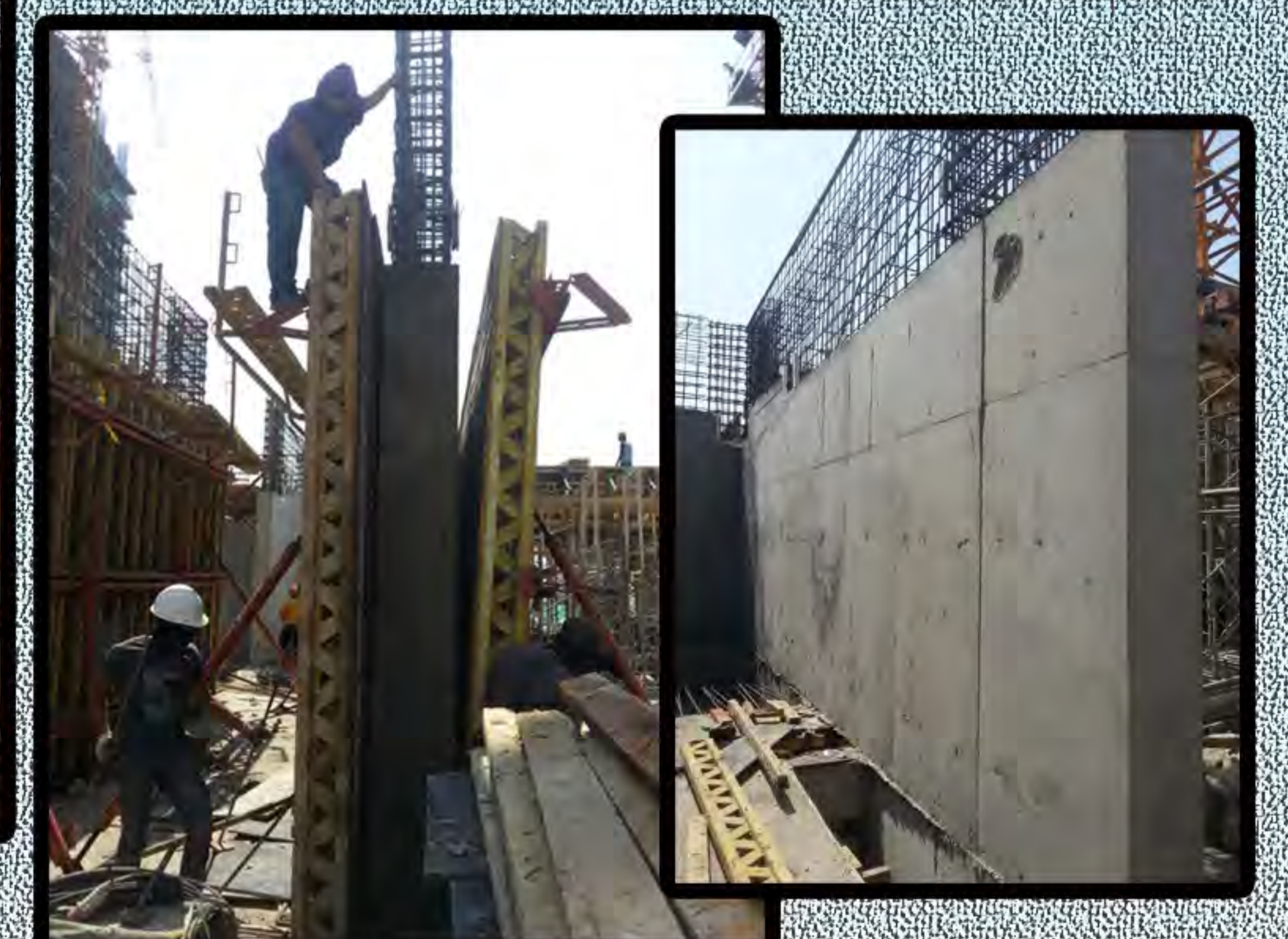
PEMBONGKARAN BEKISTING
