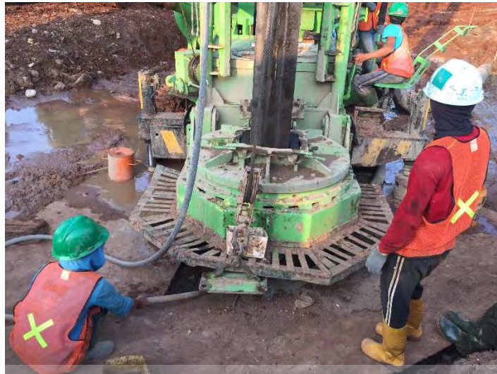
Gambar 7.2 Proses tindak lanjut cleaning endapan lumpur ( Sumber: Dokumentasi proyek 2018 )
