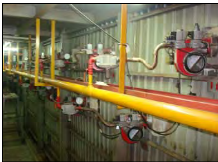
Gambar 3. Motor listrik di ruang burner
