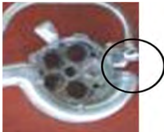
Gambar 3. Kerusakan flowline pada FR Cyl
