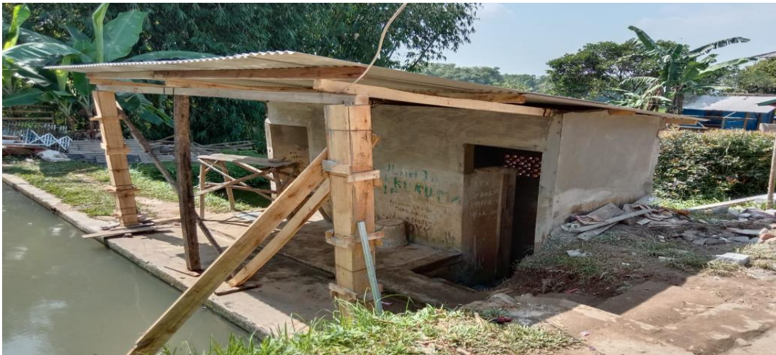
d. Pemasangan atap asbes
