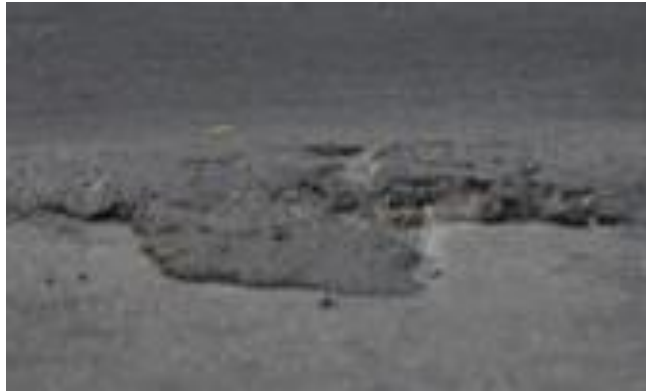
Gambar 2. 3 Retak Kegemukan ( Bleeding )
