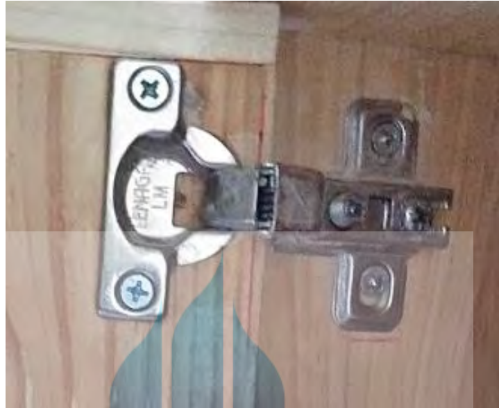
Gambar 3.29. Engsel Hidrolik Sumber: Mila Okta Safitri (2023)
