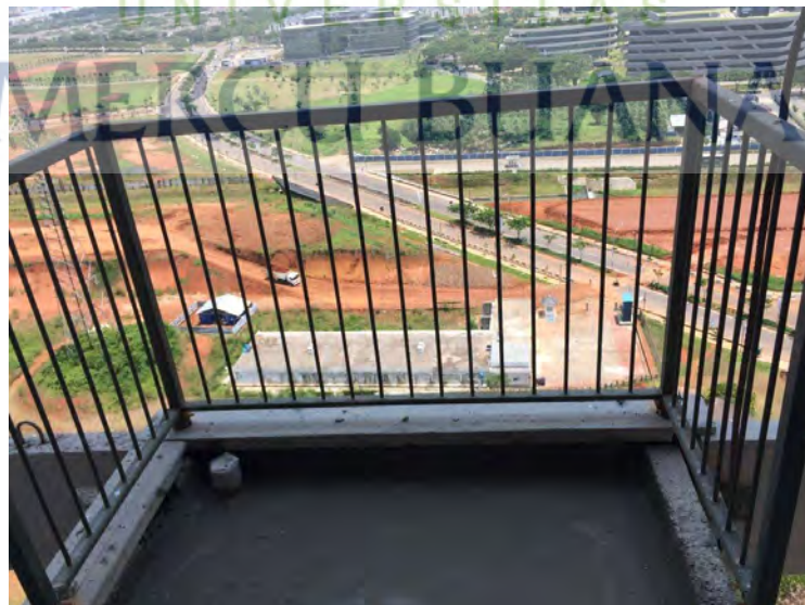
Gambar 4-43 Waterproofing pada balkon
