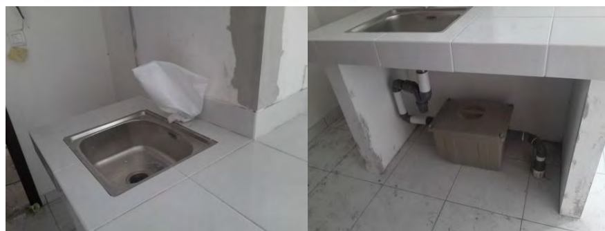
Gambar 4-56 Pemasangan utilitas meja pantry (Sumber : Dokumentasi Pribadi)
