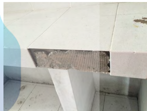
Gambar 4-62 proses pergantian keramik (Sumber : Dokumentasi Pribadi)
