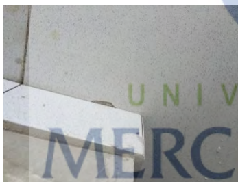
Gambar 4-61 keramik meja pantry gompal dan pecah (Sumber : Dokumentasi Pribadi)
