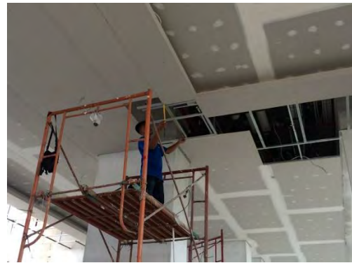
Gambar 4-34 Penutupan Plafon dengan gypsum
