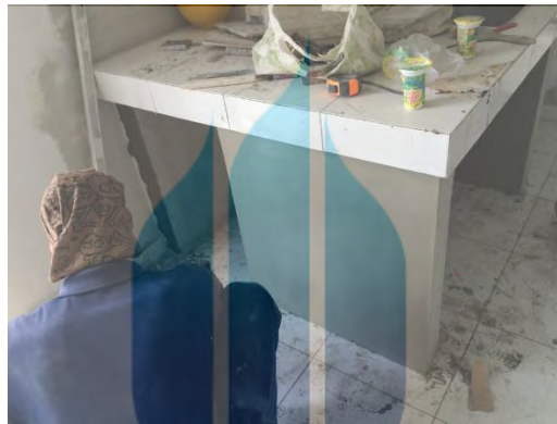
Gambar 4-57 Proses pengecatan kaki meja pantry
