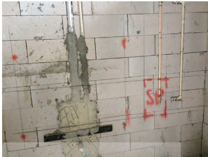
Gambar 4-7 sesudah dimarking dan mendapatkan SP (start point)
