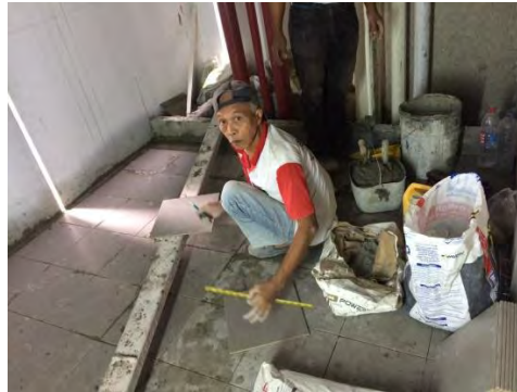
Gambar 4-25 Bahan dan Alat Pemasangan Keramik
