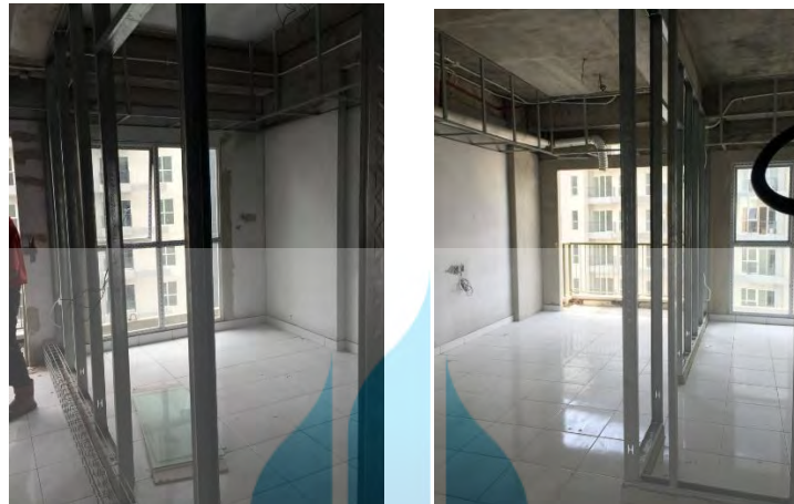
Gambar 4-9 Rangka dinding partisi (Sumber : Dokumentasi Pribadi)
