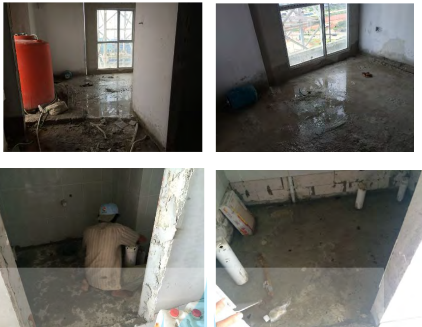
Gambar 4-24 Proses Waterproofing (Sumber : Dokumentasi Pribadi)
