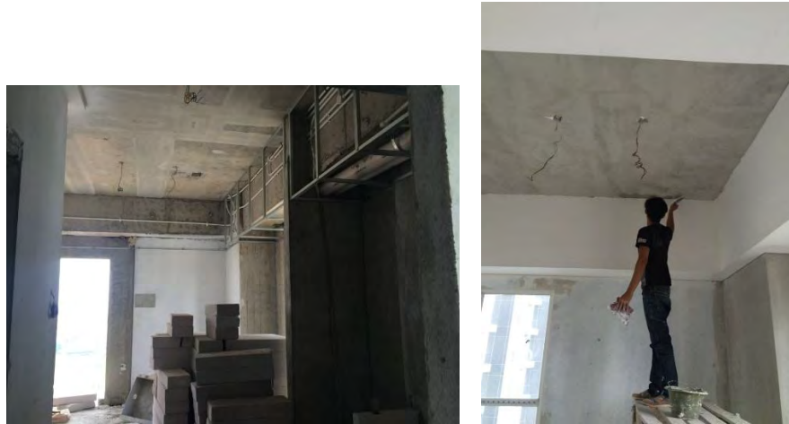
Gambar 4-31 Proses pekerjaan Plafon expose
