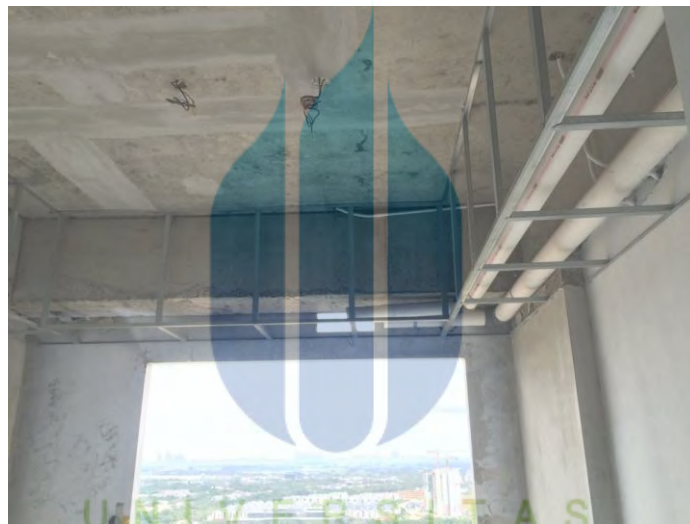
Gambar 4-33 Rangka Plafon
