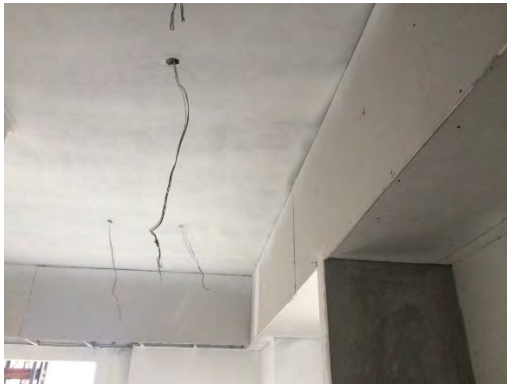
Gambar 4-34 Penutupan Plafon dengan gypsum
