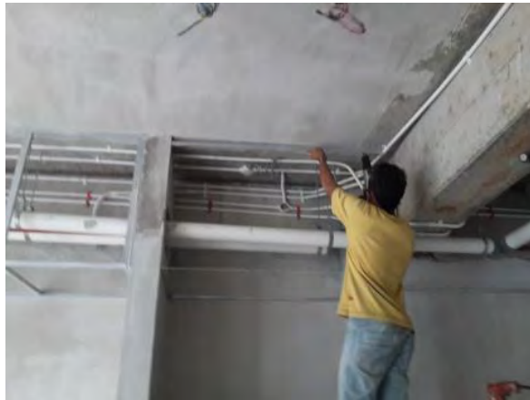
Gambar 4-32 Pemasangan Rangka Plafon
