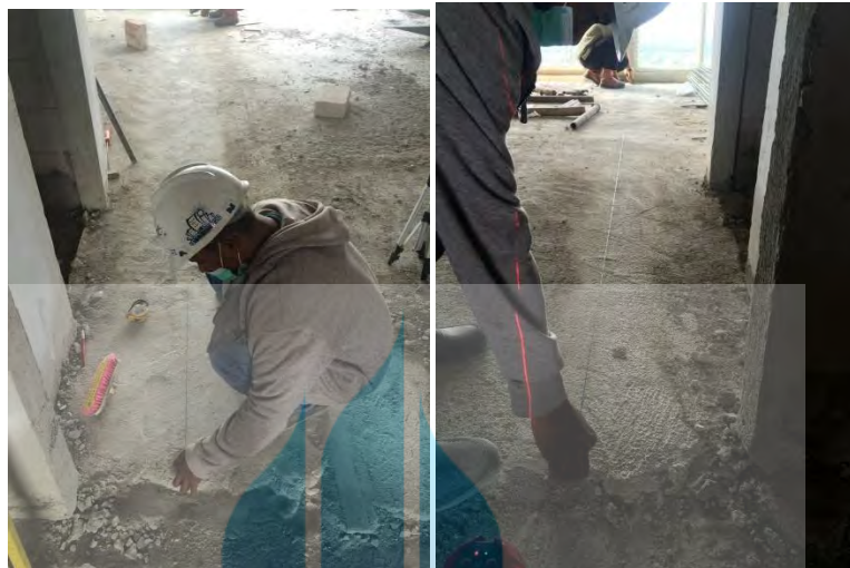
Gambar 4-22 Pemasangan Benang
