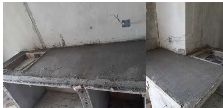
Gambar 4-54 Pengecoran meja pantry (Sumber : Dokumentasi Pribadi)
