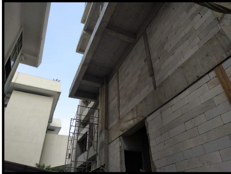
Gambar 7.1.3 Foto Kondisi Existing (Sumber: Dok. Proyek, 2019)
