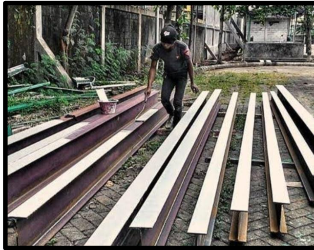
Gambar 7.3.3 Pengecatan Baja WF (Sumber: Dok. Proyek, 2019)
