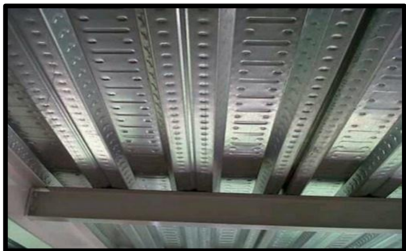
Gambar 7.3.11 Pengcoran Plat Lantai dan Perapihan (Sumber: Dok. Proyek, 2019)
