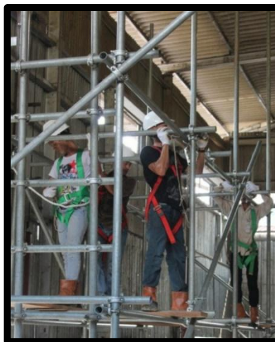
Gambar 7.3.4 Pemasangan Scaffolding (Sumber: Dok. Proyek, 2019)
