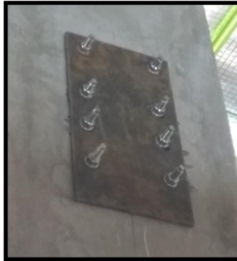
Gambar 7.3.5 Pemasangan Base Plat (Sumber: Dok. Proyek, 2019)
