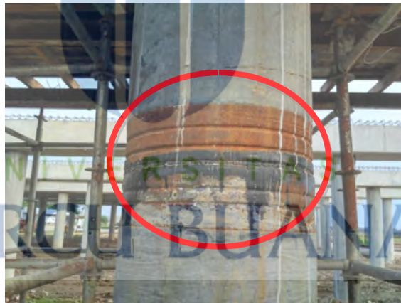
Gambar: 7.1. Sambungan tiang pancang yang berada diluar (di atas tanah) (Sumber: PT Waskita Karya Jalan Tol Cibitung-Cilincing seksi 2, 2019)
