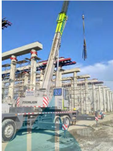
Gambar 4.12. Mobil Crane (Truck Crane)
