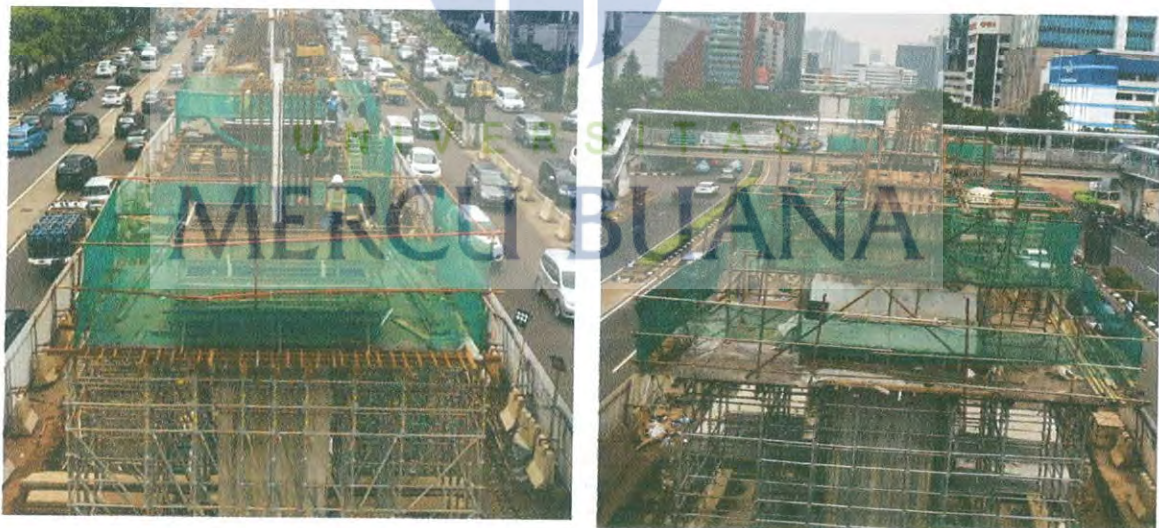
Gambar 5.1 Segemen 1 lower pierhead ( Sumber : Proyek Stasiun LRT Kuningan )
