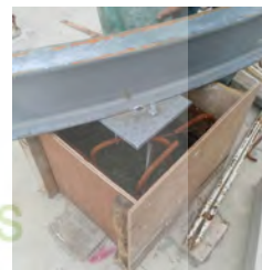
Pemasangan Bekisting
