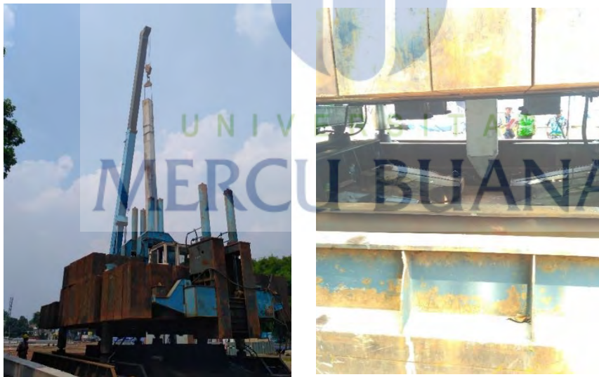
Gambar 5.6 Gambar pemasukan tiang pancang pada penjepit
