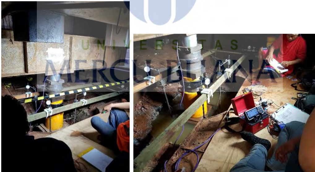
Gambar 5.18 Penempatan Hidrolik jack
