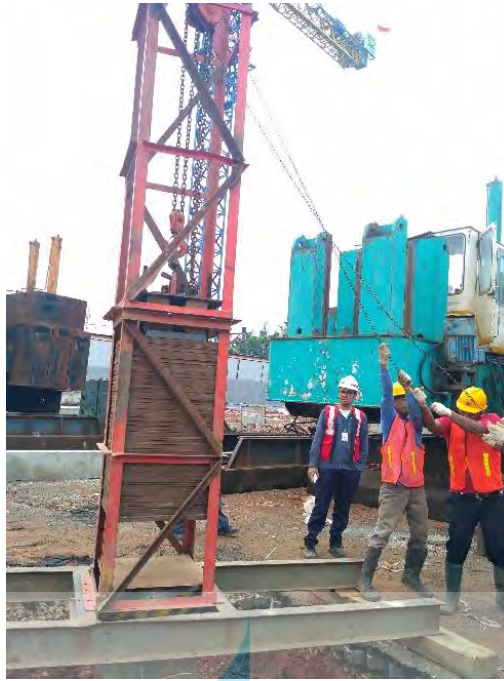
Gambar 5.25 Pengangkatan beban hammer
