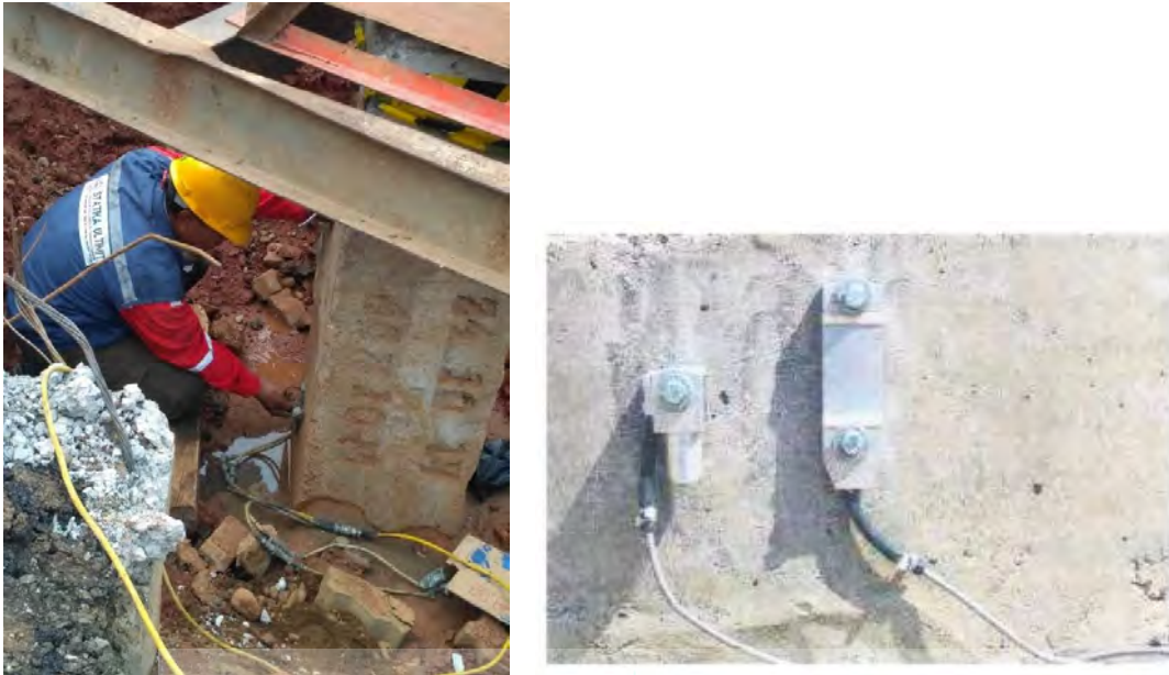
Gambar 5.23 Pemasangan sensor pada tiang pancang
