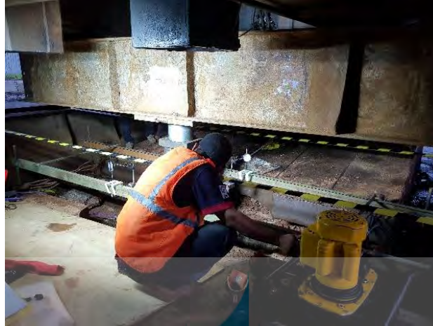
Gambar 5.17 Penempatan baja profil (beam)
