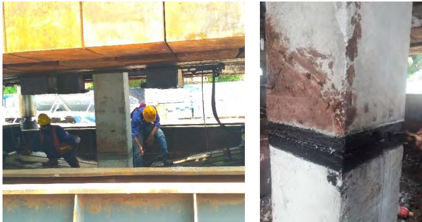
Gambar 5.11 Gambar pengecatan zincromate
