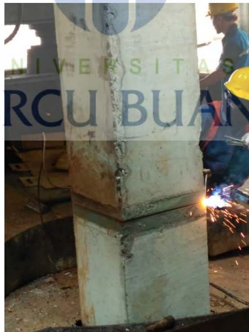
Gambar 5.10 Gambar pengelasan tiang
