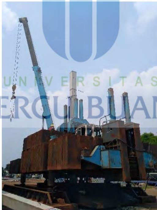
Gambar 5.16 Alat HSPD sebagai beban pengetesan
