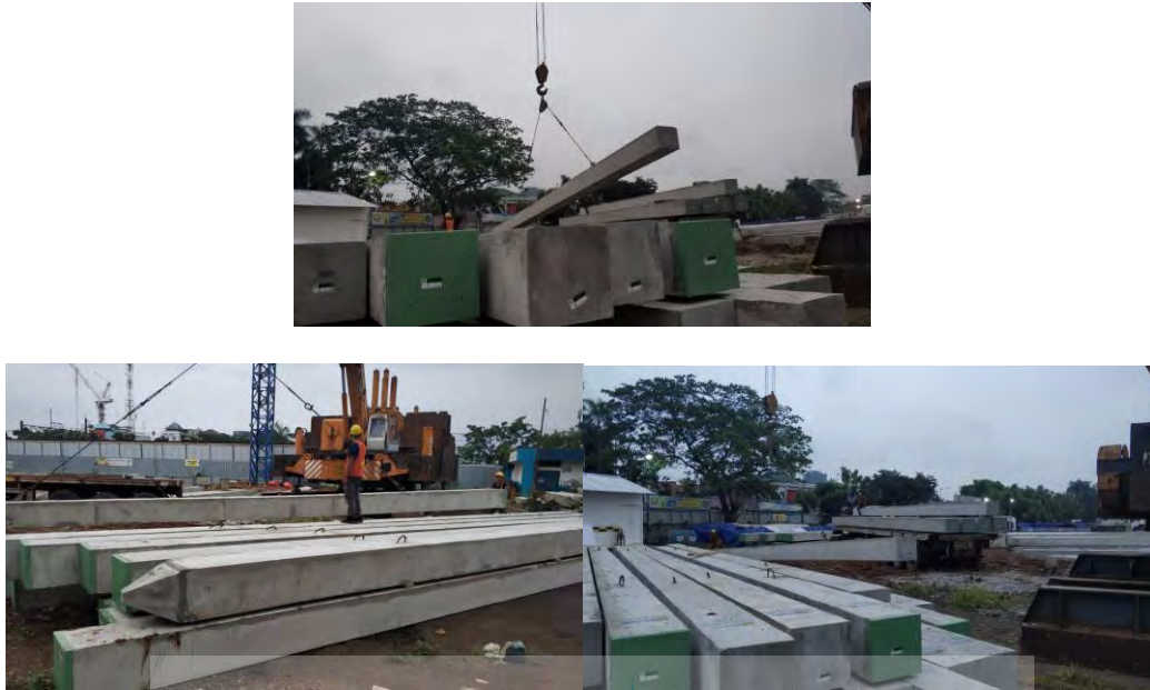
Gambar 5.4 Gambar penurunan dan penempatan tiang pancang
