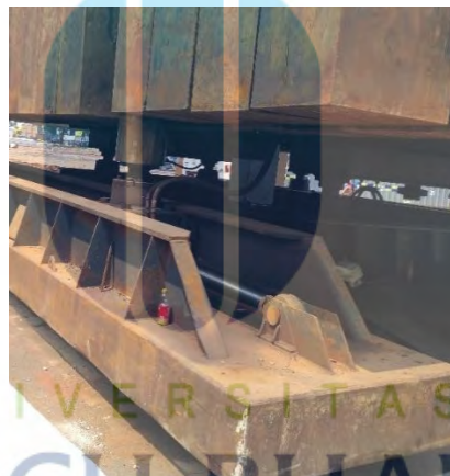
Gambar 5.12 Gambar penekanan tiang
