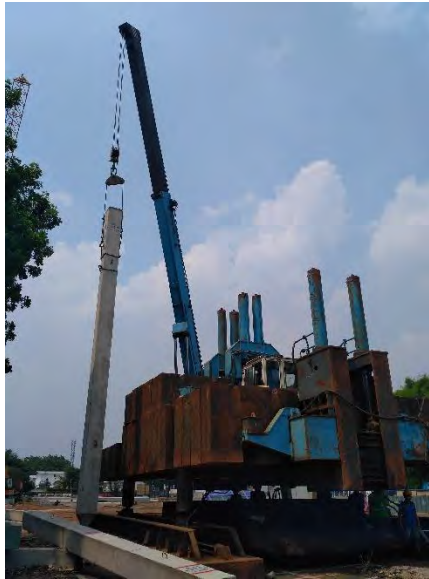
Gambar 5.5 Gambar Pengangkatan tiang pancang
