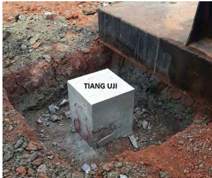
Gambar 5.22 Persiapan tiang uji
