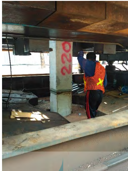
Gambar 5.9 Gambar sambungan tiang
