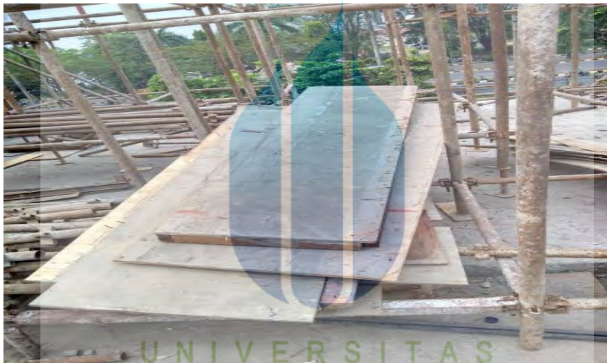
Gambar 4.6 - Bekisting Sumber : Proyek, 2018
