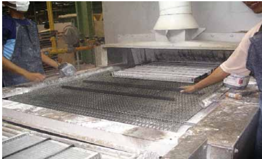
Gambar 4.1. Pemasangan tatakan plat H
