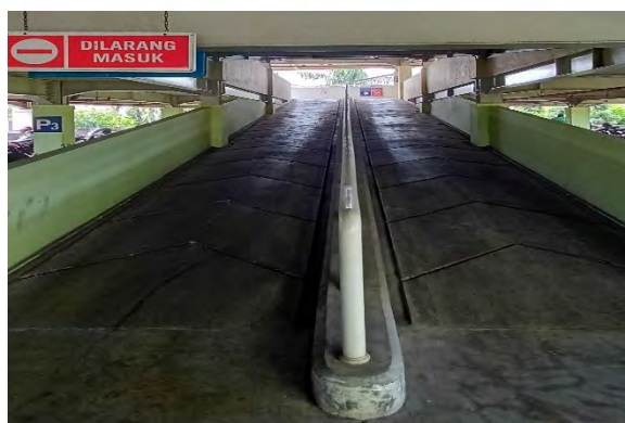
Gambar IV-6 Ramp Untuk Akses Antar Lantai Gedung Parkir Sepeda Motor (Sumber : Data Penulis, 2021)
