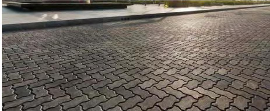
Gambar IV.15 Paving Block Untuk Pedestrian Luar Tapak
