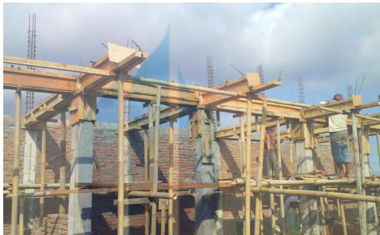
Gambar IV.12 Struktur Beton Bertulang
