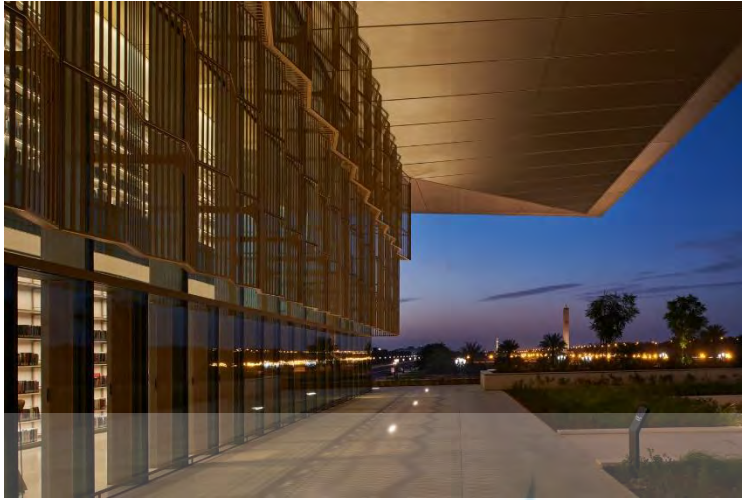
Gambar 2.6 View dekat Atap Gedung Kebudayaan dan perpustakaan Sumber https://www.archdaily.com
