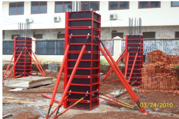
Gambar 5. Aplikasi Bekisting LICO untuk bangunan rendah
