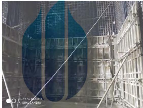
Gambar 5. 2 Bekisting Knock Down Plat Baja dan Besi Hollow
