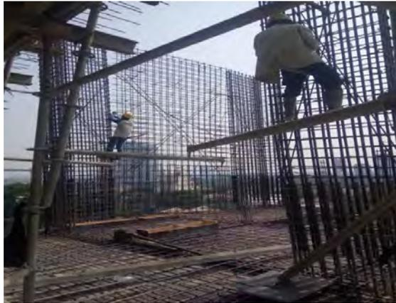
Gambar 5. 5 Pembesian Shear Wall
