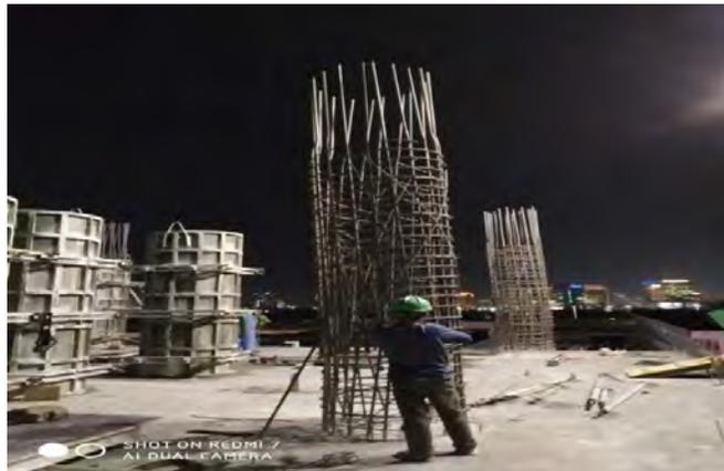
Gambar 5. 3 Pembesian Kolom Spiral
