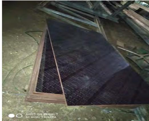
Gambar 5. 1 Plywood 12 Mm Phenolic 1 Muka Untuk Pelat Dan Balok
