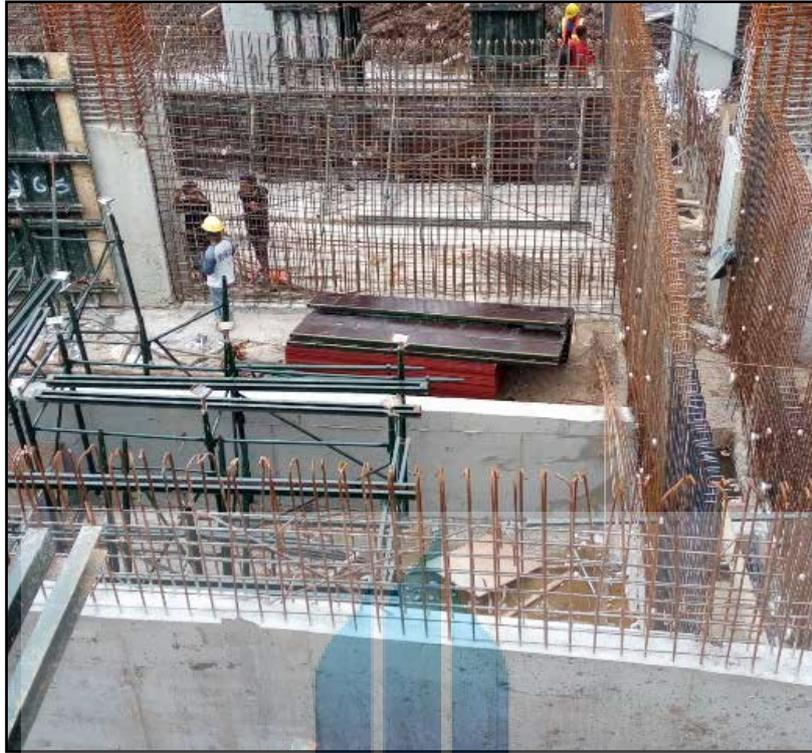
**Gambar 7.14 Pekerjaan Pengecoran Kolom dan Dinding Pemisah**
