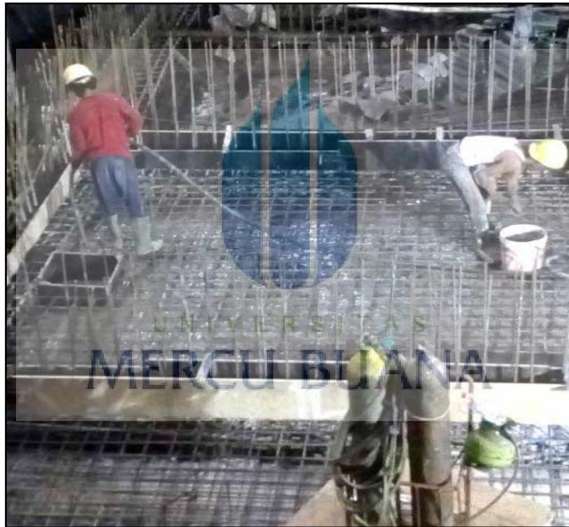
**Gambar 7.13 Pekerjaan Pengecoran Pelat dan Balok**
