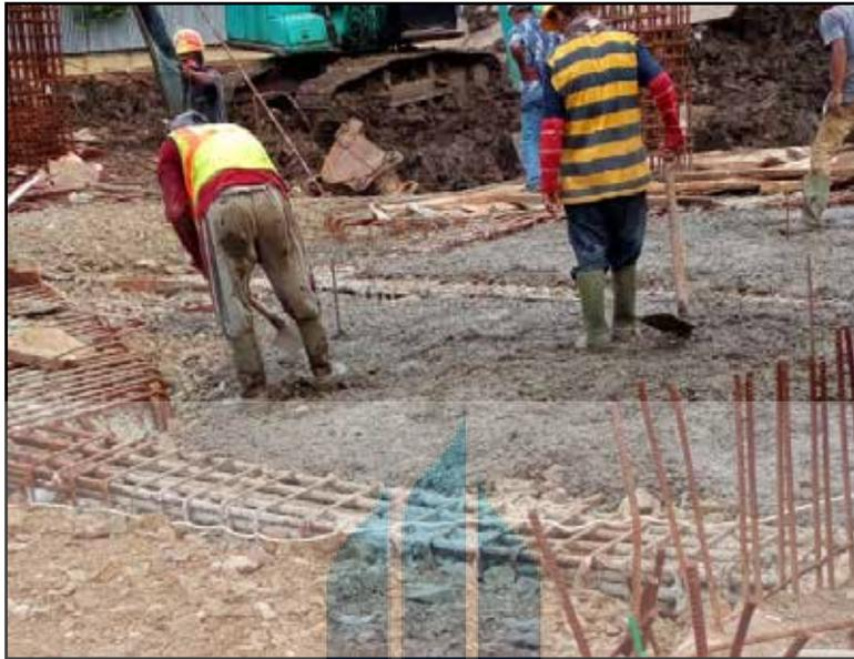
Gambar 7.7 Pembuatan Lantai Kerja
