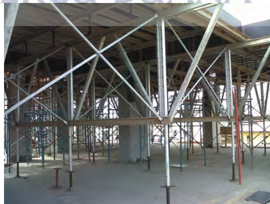
Gambar 7.2 Aluma Lite Truss Table Form yang telah terpasang
