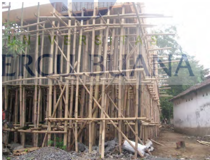
Gambar 7.2 Bekisting Konvensional
