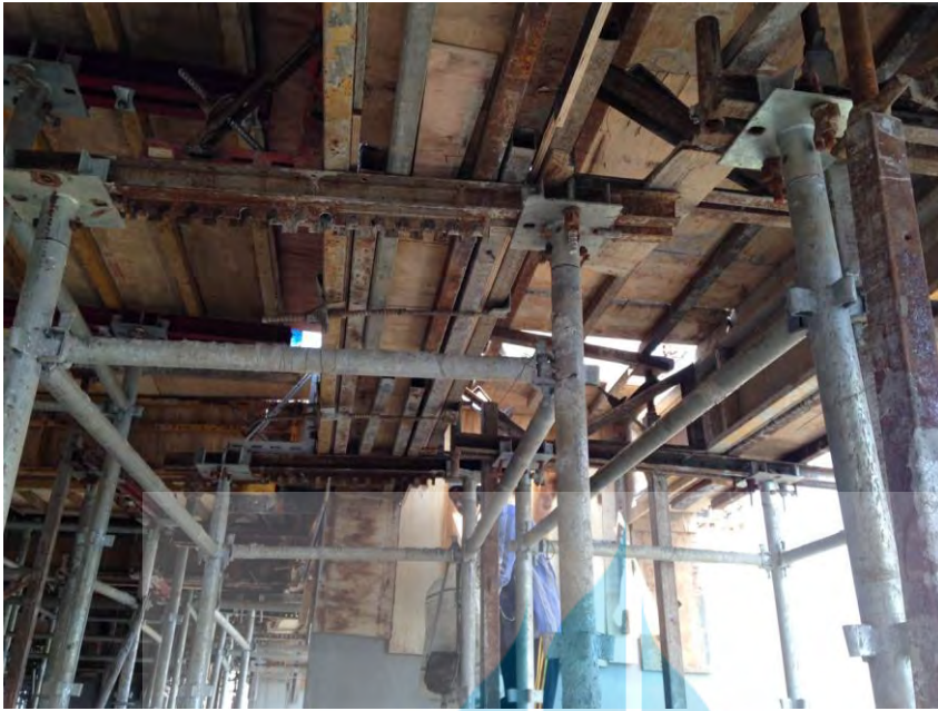
Gambar 7.6 Pemasangan UNP Double
