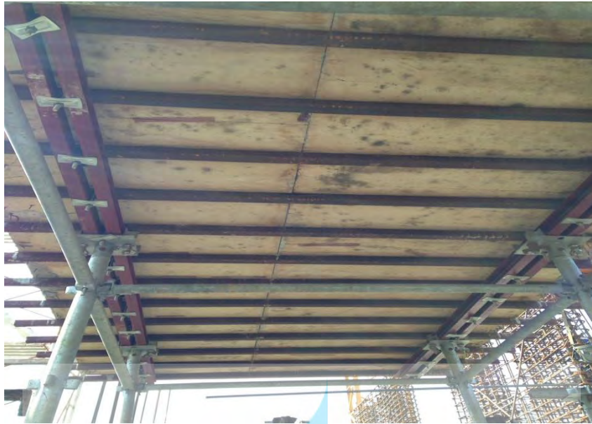
Gambar 7.7 Pemasangan Hollow
