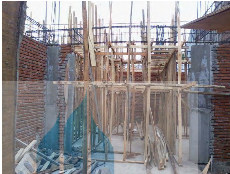
Gambar 7.1 Bekisting Konvensional
