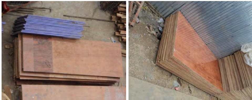
Gambar 5. 16 Kayu untuk bekisting pelat lantai
