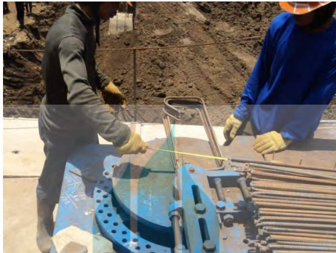
Gambar 5. 18 Pembuatan tulangan balok
