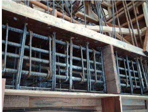
Gambar 5. 24 Pemasangan kawat ayam sebagai stop cor
