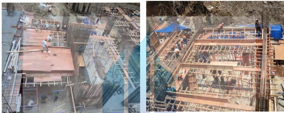
Gambar 5. 17 Pemasangan bekisting pelat lantai
