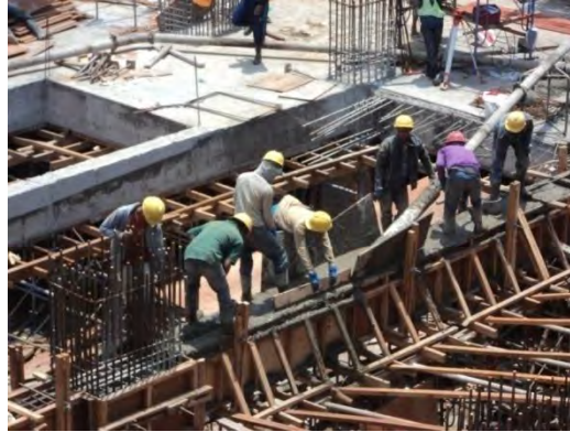
Gambar 5. 25 Proses pengecoran balok
