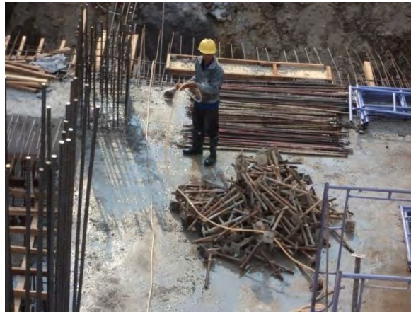
Gambar 5. 27 Perawatan beton dengan menyiramkan air di atasnya
