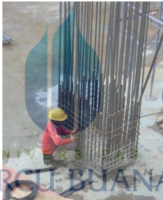
Gambar 5. 12 Penyambungan kolom
