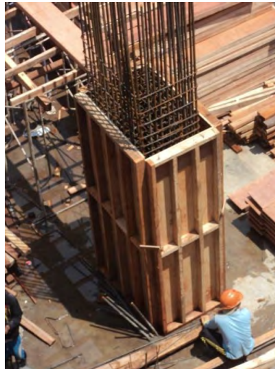
Gambar 5. 13 Bekisting kolom
