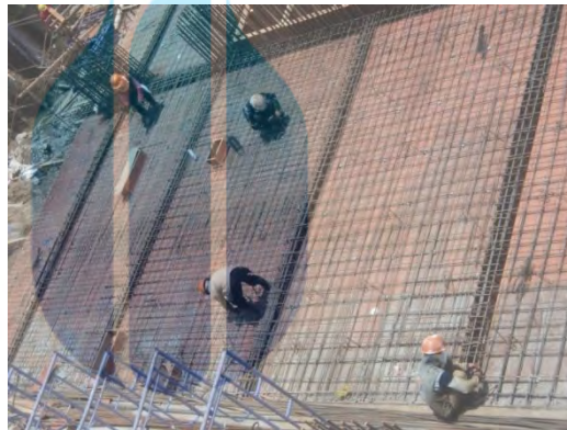
Gambar 5. 23 Tulangan pelat lantai dengan decking besi
