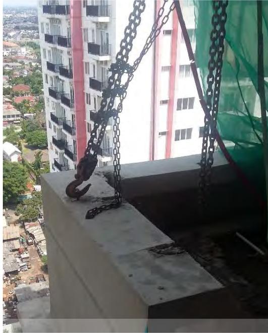
**Gambar 40: Chain Block dikaitkan ke Precast**
