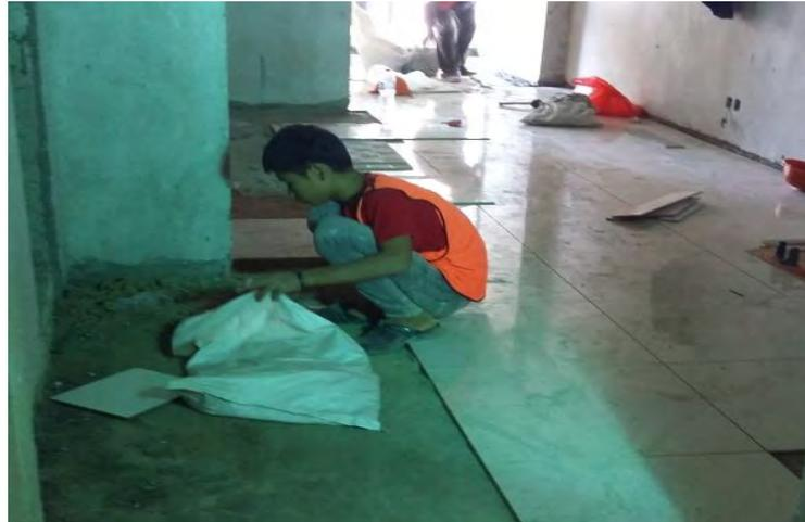
**Gambar 14: Pemasangan Keramik Lantai**
