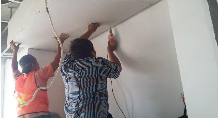
**Gambar 27: Bor gypsum board pada rangka plafond**
