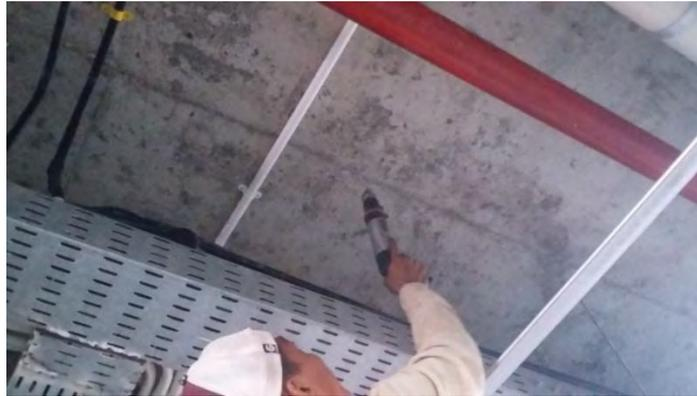
**Gambar 23: Ramset Nail Gun untuk pasang rangka Plafond**
