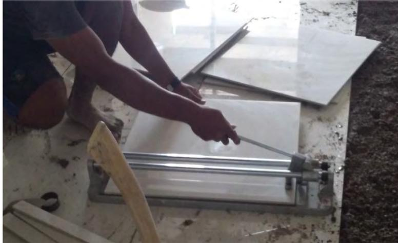
**Gambar 11: Pemotongan Keramik**
