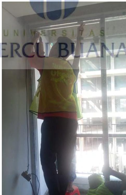
Gambar 34: Pemasangan Rangka Jendela
