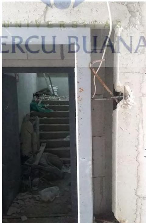
**Gambar 32: Detail Sambungan Pintu Besi ke Dinding**
