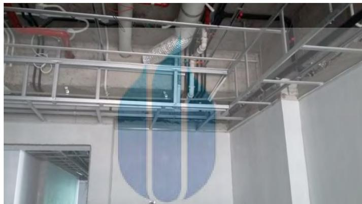
**Gambar 24: Pemasangan Rangka Plafon**
