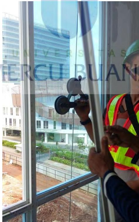
**Gambar 36: Pemasangan Kaca ke Rangka**
