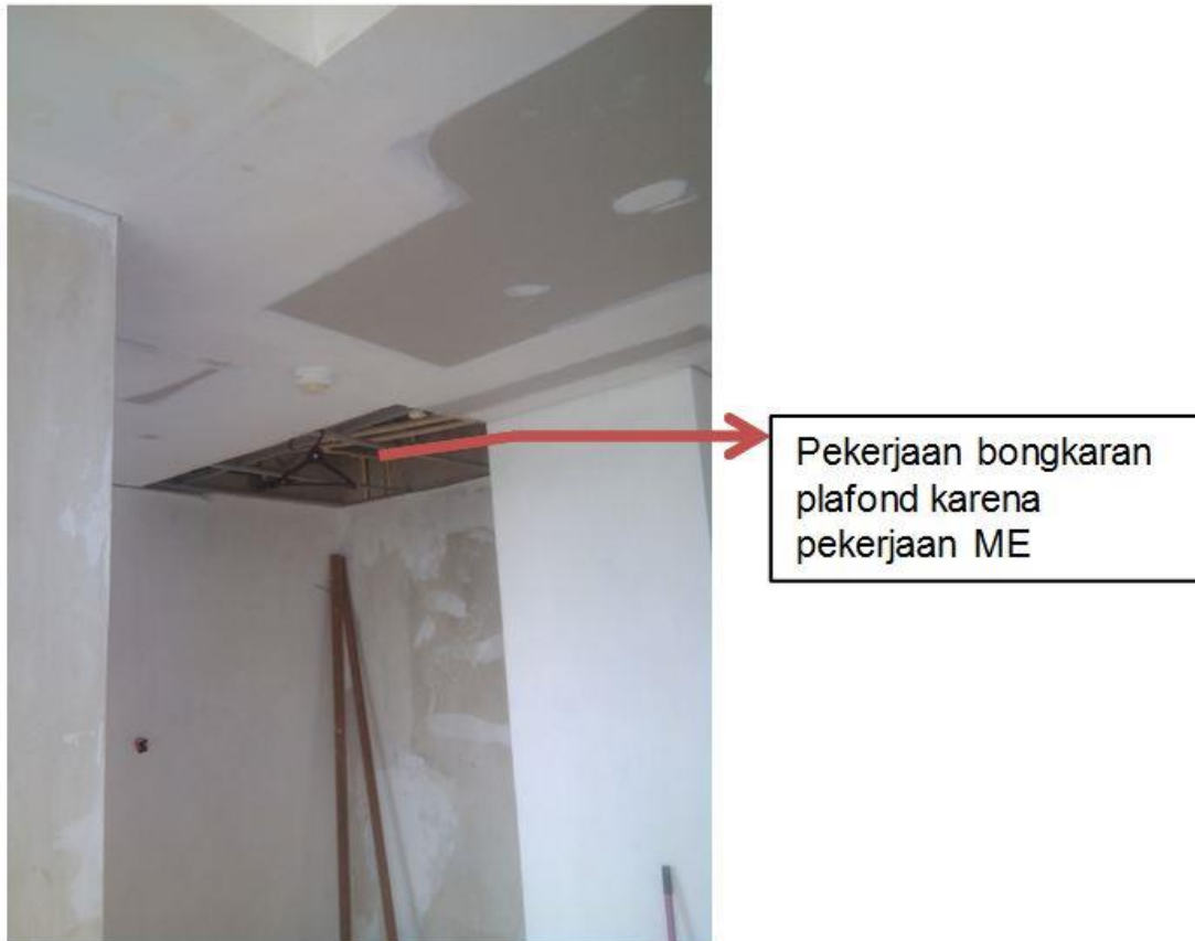
Gambar 9. Bongkaran pekerjaan ME
