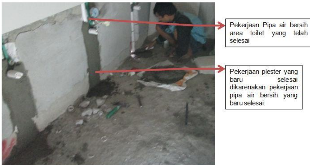
Gambar 4. Bobok ulang dinding untuk instalasi
