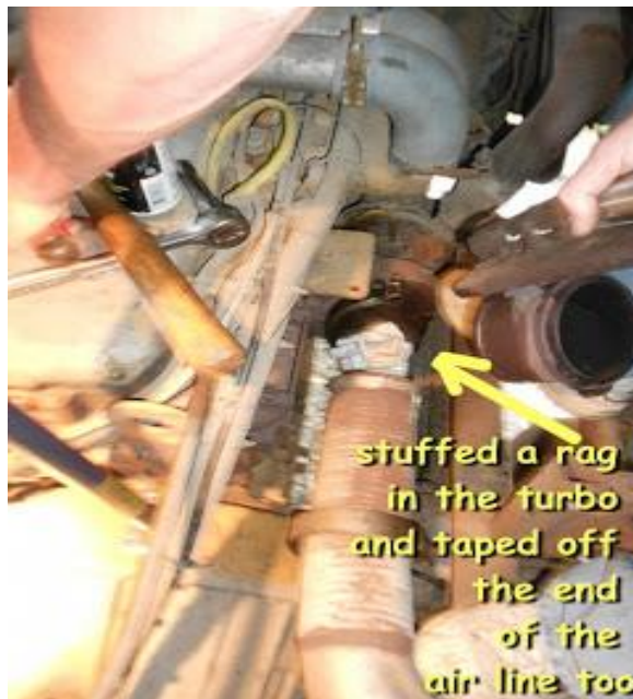
Gambar 4.10 Pembersihan Flange Turbocharger dan Pipa Gas Buang (Sumber: dokumen pribadi)
