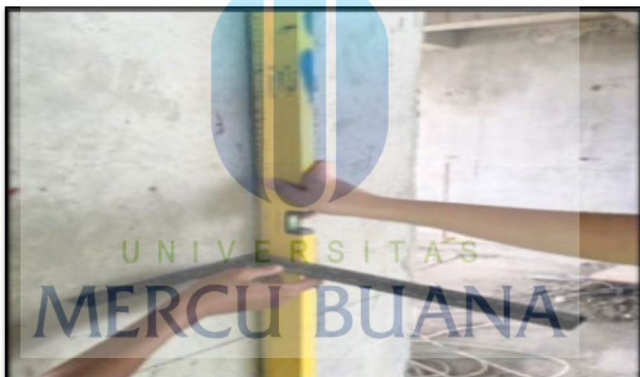
Gambar 6.11 QC Permukaan Vertikal Kolom
