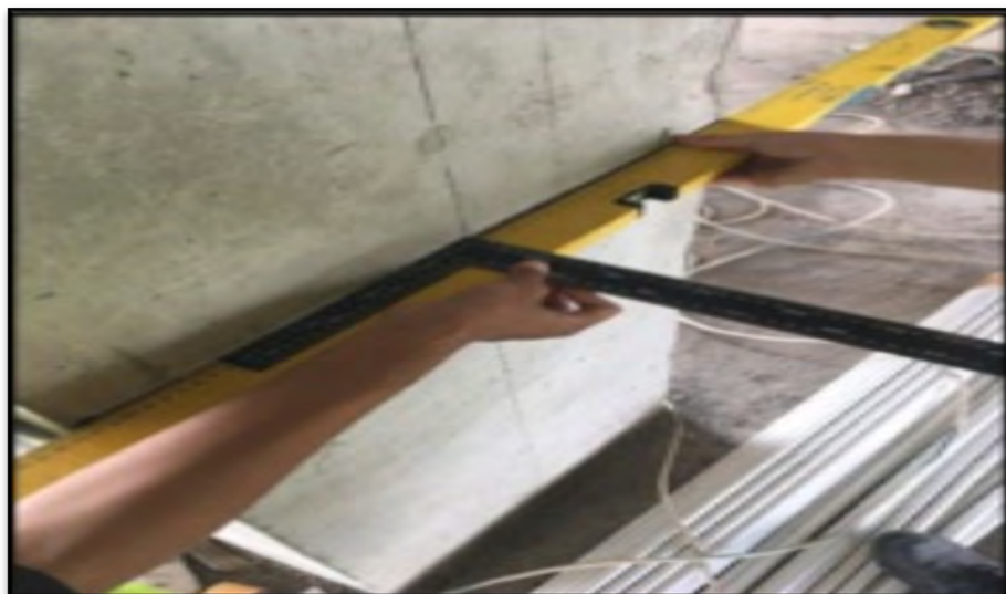
Gambar 6.10 QC Permukaan Horizontal Kolom
