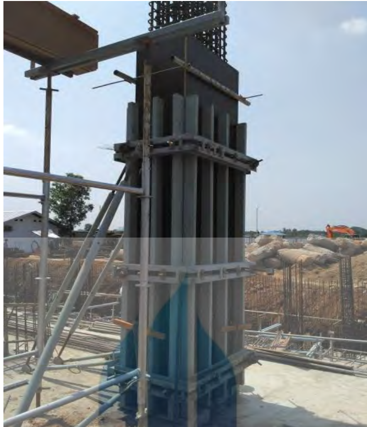
Gambar 2.5. Pekerjaan kolom dalam proyek pembangunan Apartemen Kaliana Metland Cileungsi
