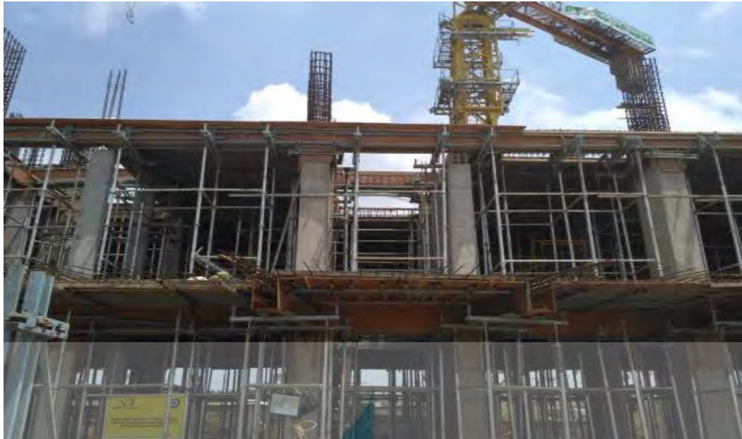
Gambar 2.4. Pekerjaan struktur atas dalam proyek pembangunan Apartemen Kaliana Metland Cileungsi (sumber : dokumentasi penulis, 2018)
