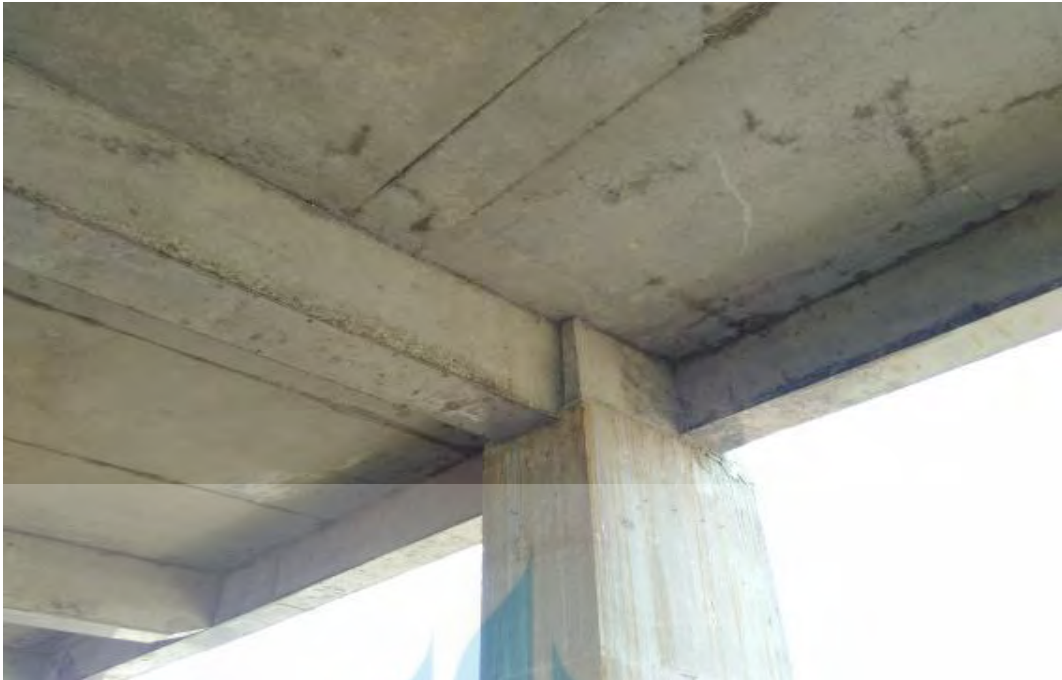
Gambar 2.6. Pekerjaan balok dalam proyek pembangunan Apartemen Kaliana Metland Cileungsi
