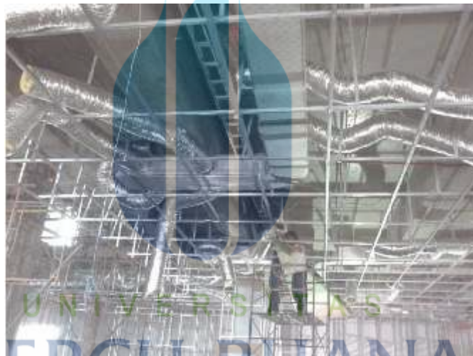
Gambar 2.4. Sistem Ducting pada AC Sentral
