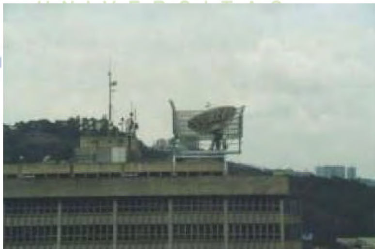
Gambar 3.28 Penggunaan Mesh screening sebagai interference shielding di Caracas
