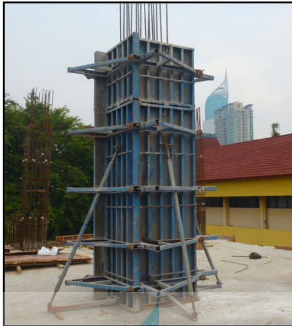
Gambar 5.2 Pemasangan Bekisting Kolom
