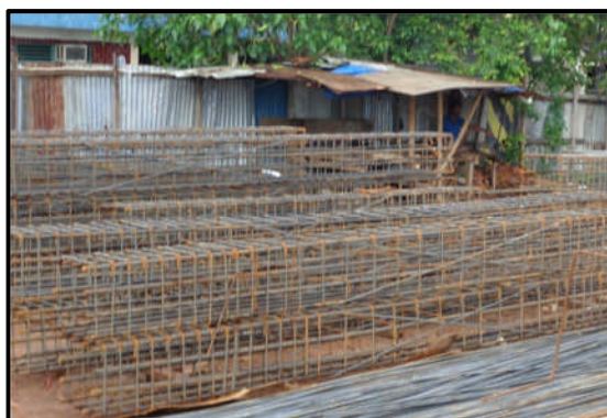
Gambar 5.1 Besi Tulangan Setelah Pabrikasi
