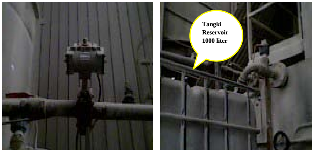
Gambar 5.13. Pemasangan Sistem Reservoir Air Inlet Utama Spray Drier
