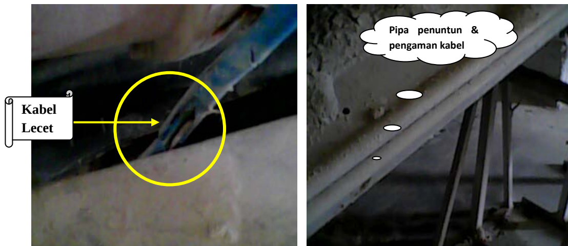
Gambar 5.11. Perbaikan Sistem Pengaman Jalur Kabel Vibrating Screen
