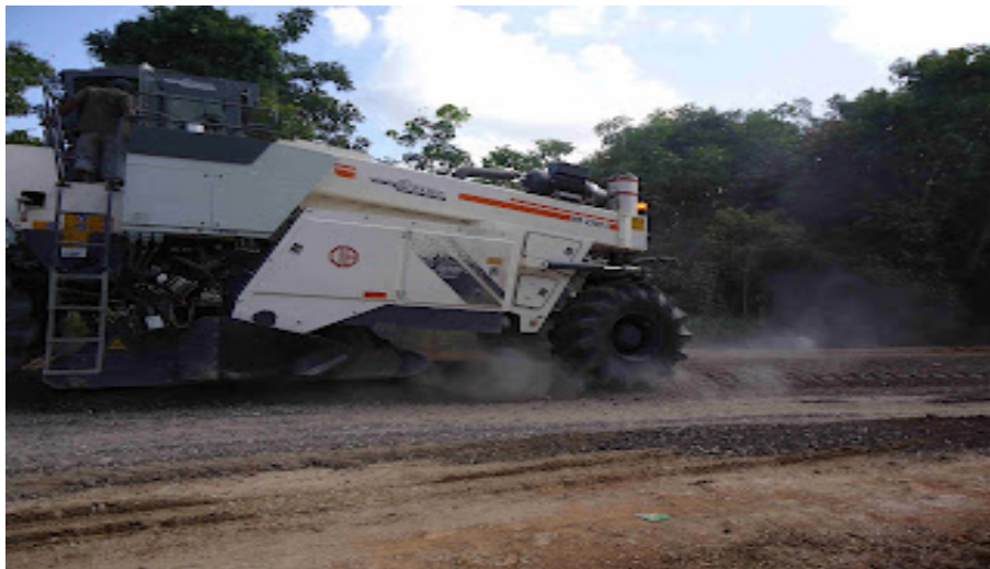
Gambar: 2.2. Proses Milling Menggunakan Unit WIRTGEN 2500S
