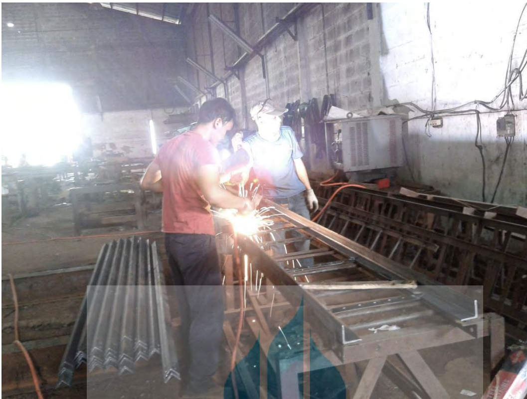
Gambar 3. 11 Perakitan tangga dan rak kabel
