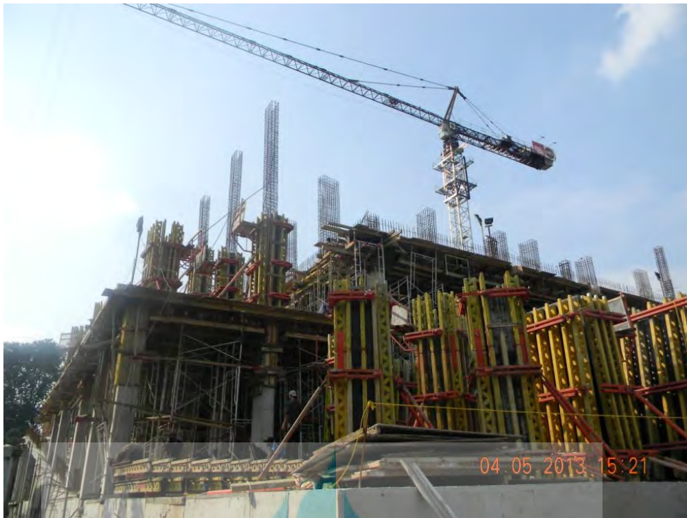
PEKERJAAN BEKISTING CORE WALL
