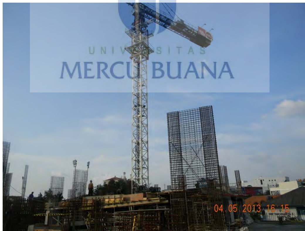
PEKERJAAN PEMBESIAN SHEAR WALL
