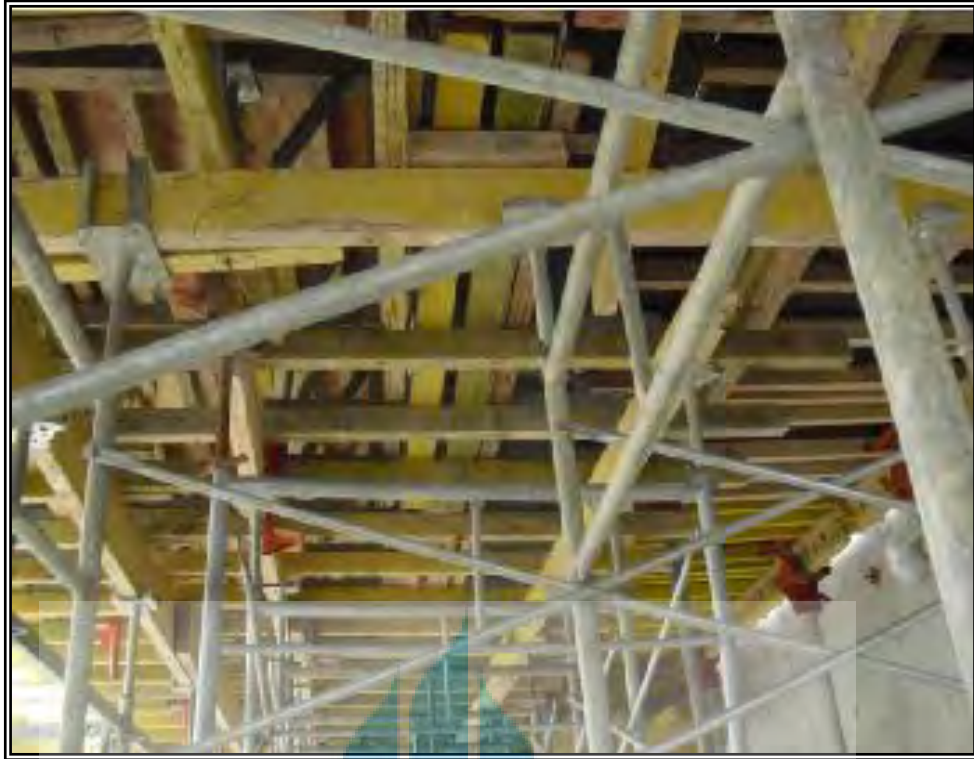
PEKERJAAN PERKUATAN BESKISTING BALOK
