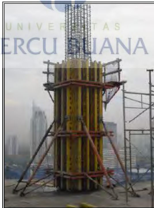
PEKERJAAN BEKISTING DAN PEMBESIAN KOLOM
