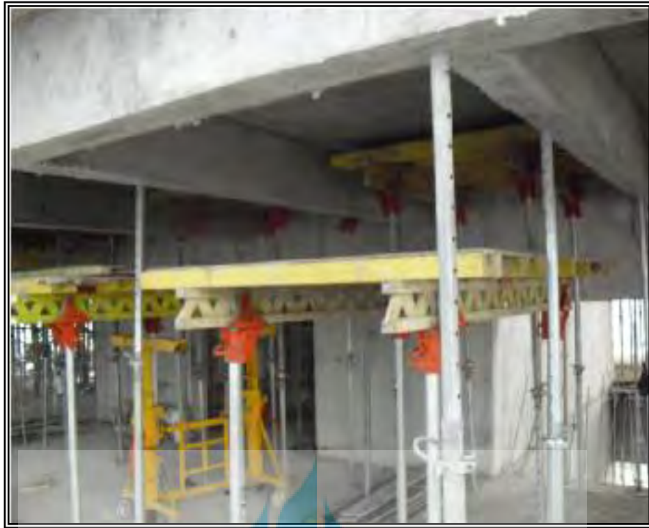
PEKERJAAN PEMBONGKARAN TABLE FORM
