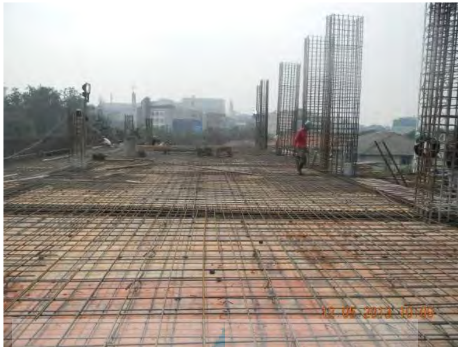
PEKERJAAN PEMBESIAN PELAT LANTAI
