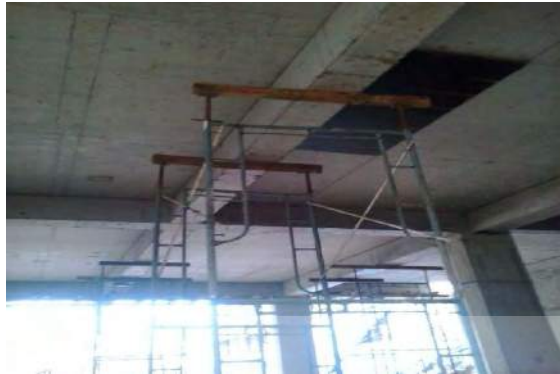
Gambar 5.26 pembongkaran bekisting balok
