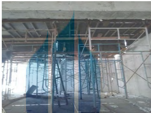
Gambar 5.39 pemasangan perancah pada ramp
