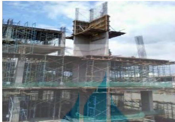
Gambar 5.31 bekisting pada shear wall
