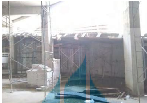
Gambar 5.43 pembongkaran bekisting ramp
