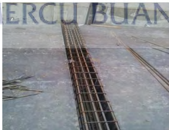
Gambar 5.24 pembesian pada balok
