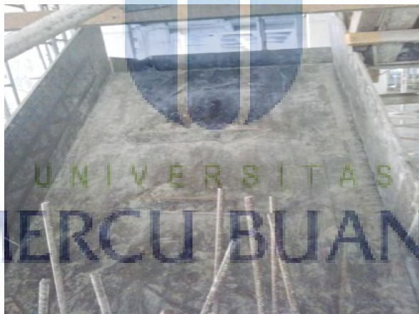
Gambar 5.35 bekisting tangga
