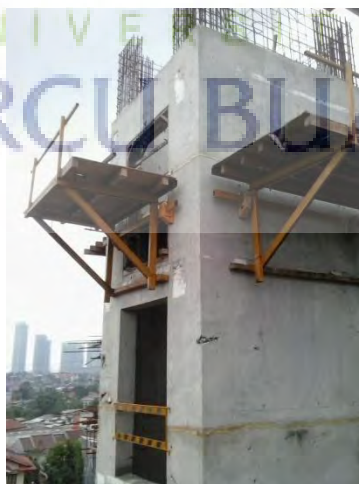
Gambar 5.34 hasil pembongkaran bekisting core wall
