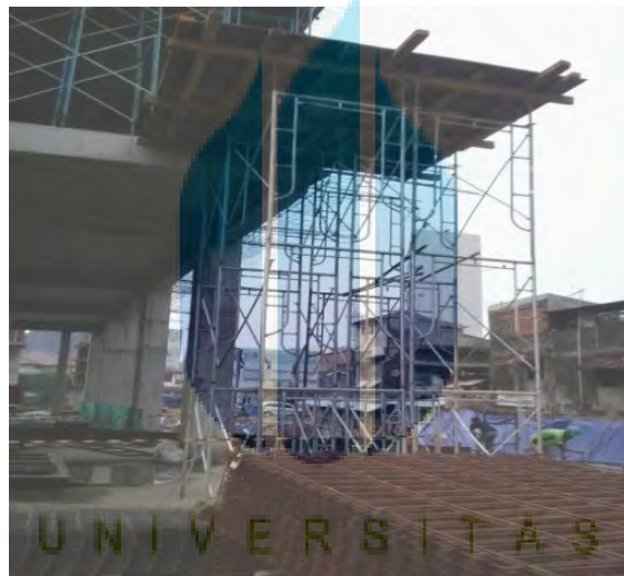
Gambar 5.22 pemasangan scaffolding balok
