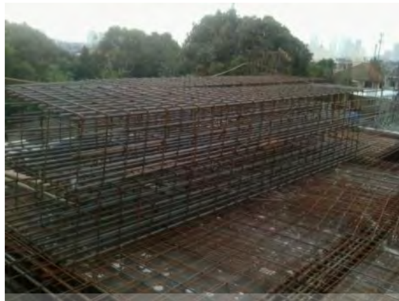
Gambar 5.10 pembesian kolom
