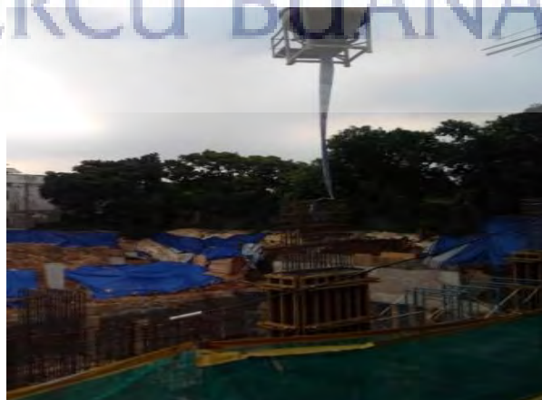
Gambar 5.13 pengecoran kolom
