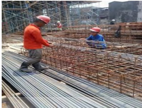
Gambar 5.11 pekerjaan pembesian kolom
