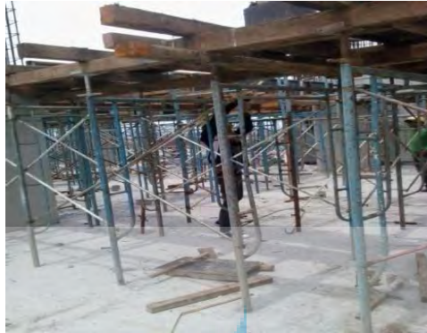
Gambar 5.23 pekerjaan bekisting balok
