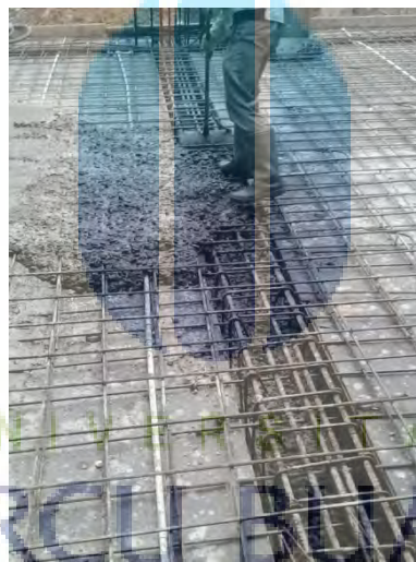
Gambar 5.25 pengecoran balok
