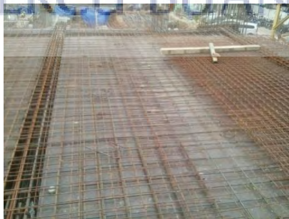
Gambar 5.27 pekerjaan pembesian pelat lantai
