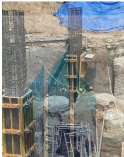
Gambar 5.14 pembongkaran bekisting kolom
