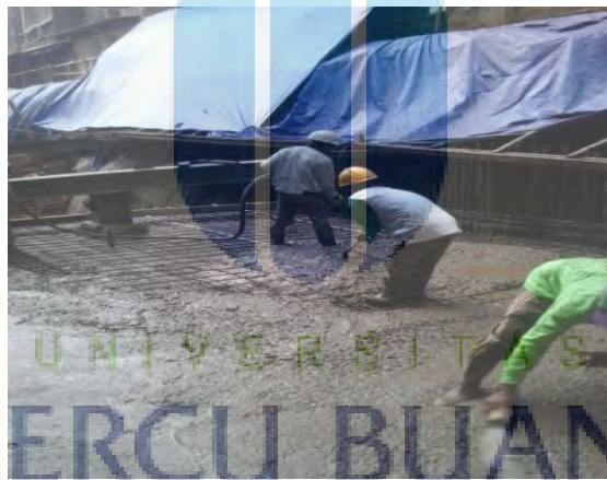
Gambar 5.28 pengecoran pelat
