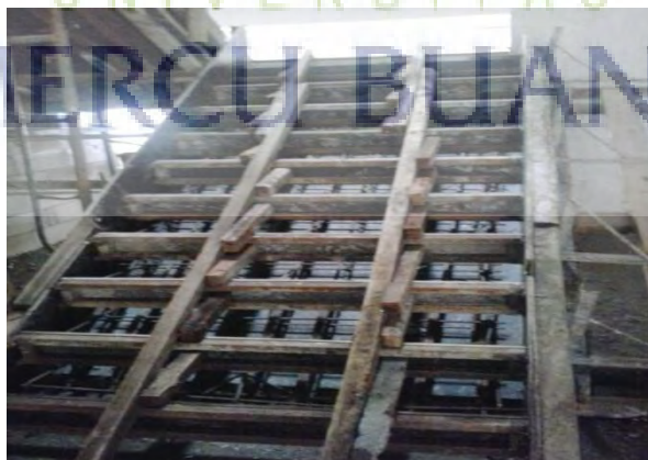
Gambar 5.37 pembuatan sekat tangga
