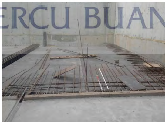
Gambar 5.41 pembesian ramp
