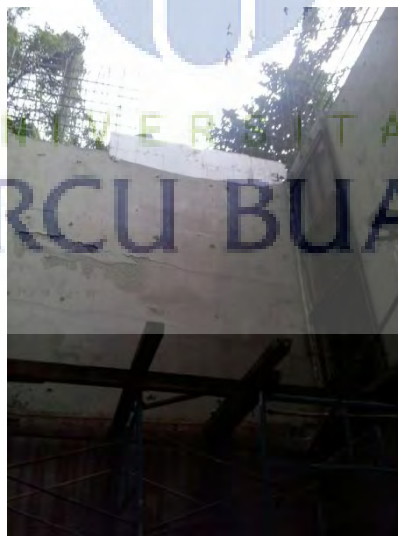
Gambar 5.17 pemasangan blockout pada retaining wall
