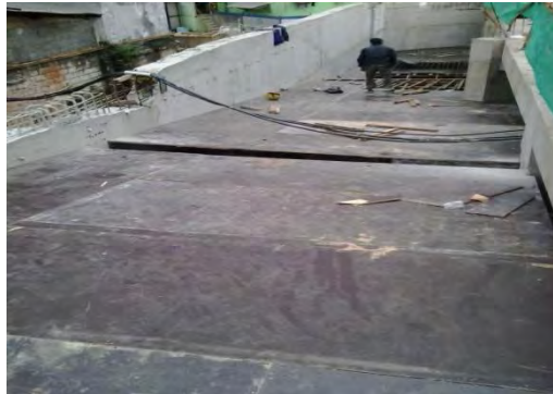
Gambar 5.40 pemasangan bekisting ramp
