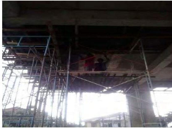
Gambar 5.29 pembongkaran bekisting pelat
