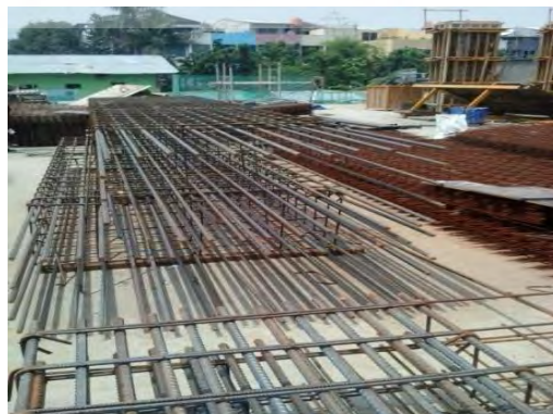
Gambar 5.30 pembesian shear wall
