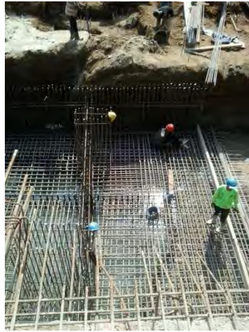
Gambar 5.8 pembuatan raft pondasi
