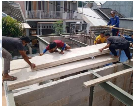
Gambar 2. 11 Pemasangan Panel Lantai
