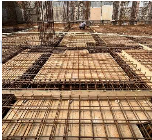
Gambar 2. 1 Pemasangan Metode Konvensional
