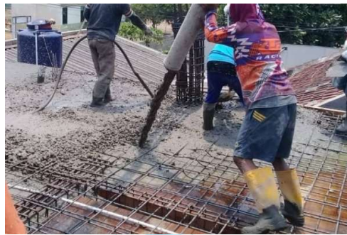
Gambar 2. 8 Pengecoran Pelat Lantai
