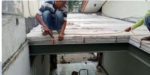
Gambar 2. 13 Pemasangan Angkur
