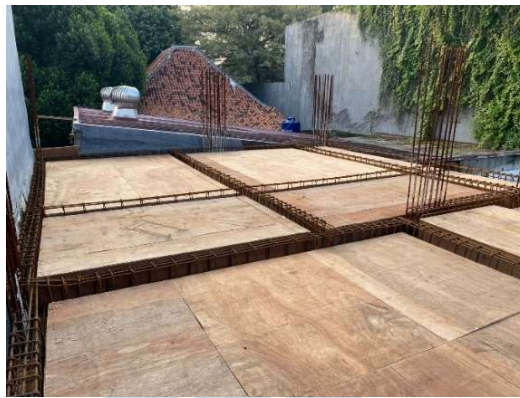
Gambar 2. 4 Bekisting Metode Konvensional
