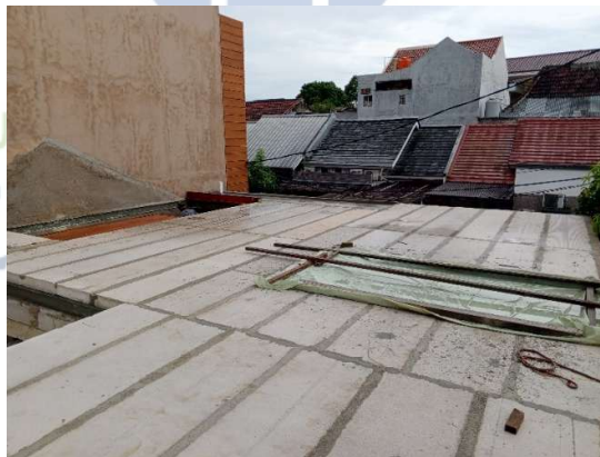
Gambar 2. 2 Panel Lantai Beton Ringan Bertulang
