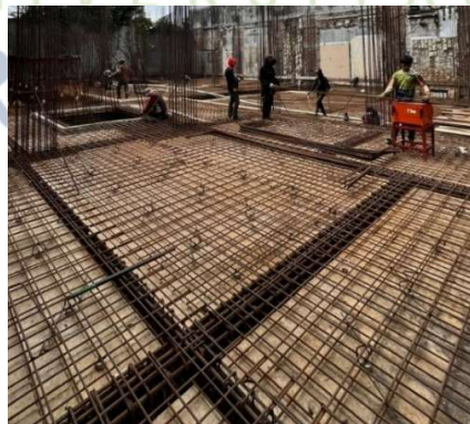
Gambar 2. 7 pemasangan Tulangan Besi Pelat Lantai
