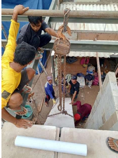
Gambar 2. 10 Pekerjaan Pengangkatan Panel Lantai
