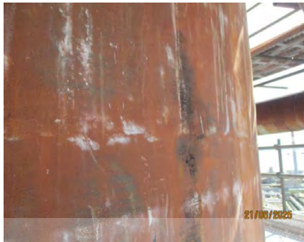
Gambar 4.2 Shell 2 Mulai Mengalami Perubahan Warna
