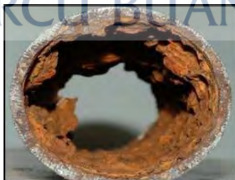
Gambar 2.5 Bagian Korosi Naftanela di Unit Kilang
