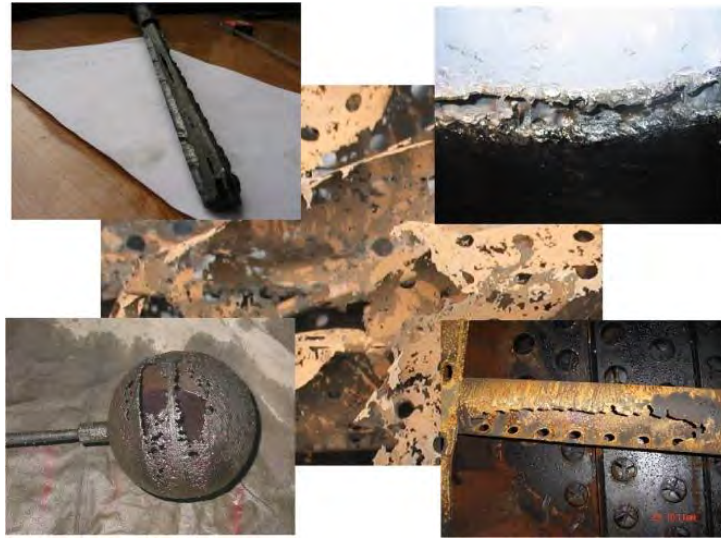
Gambar 2.11 Korosi Akibat Asam pada Kilang Minyak Mentah
