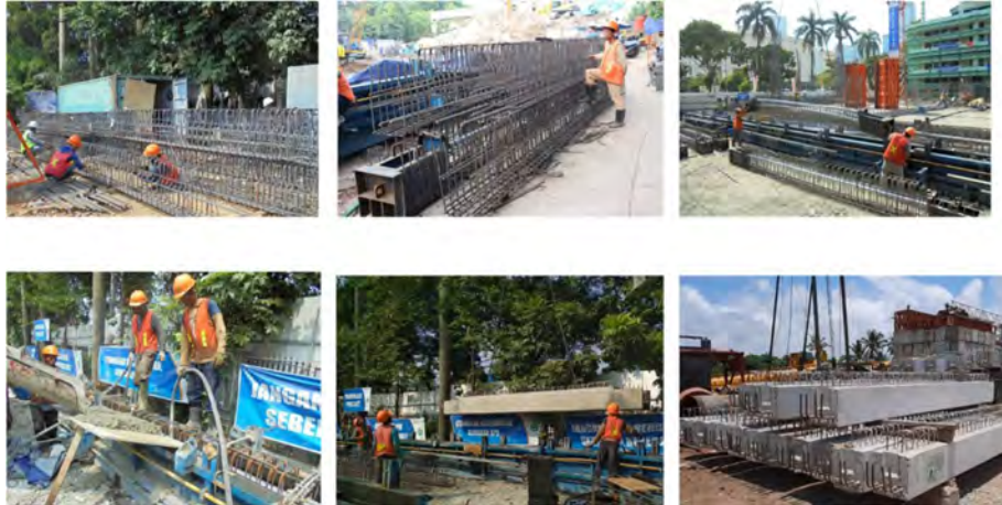
Gambar 3. 10 Ilustrasi proses tahapan produksi struktur balok pracetak
