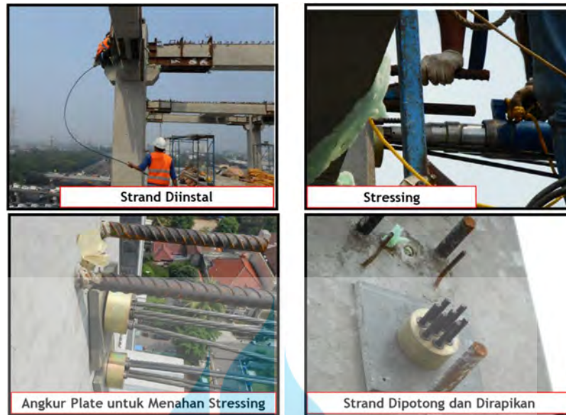
Gambar 2. 7 Proses stressing elemen joint balok pada sambungan mekanis struktur kolom
